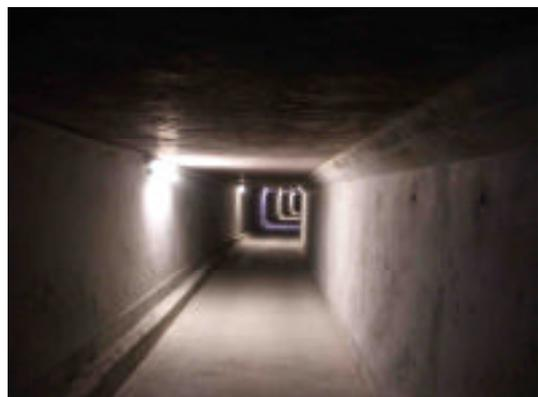
圖 40、主隧道下方救援用途之隧道
