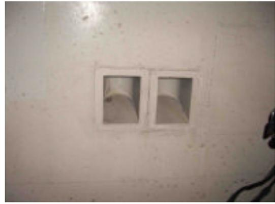
圖 4、位於隧道壁下方之一處進氣管道
