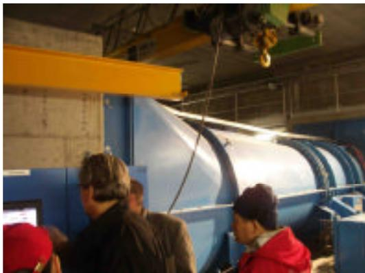
圖 7、排煙管道內的風機
