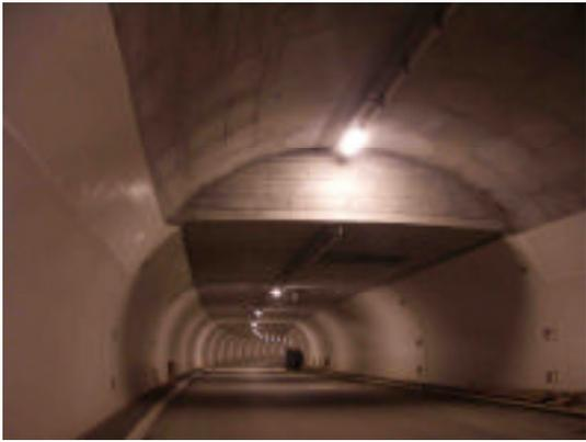
圖 25、Uetliberg 隧道上方獨立排煙管道
