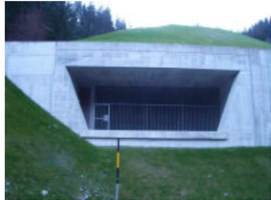
圖 6、隧道中位於上方排煙管道之出口
