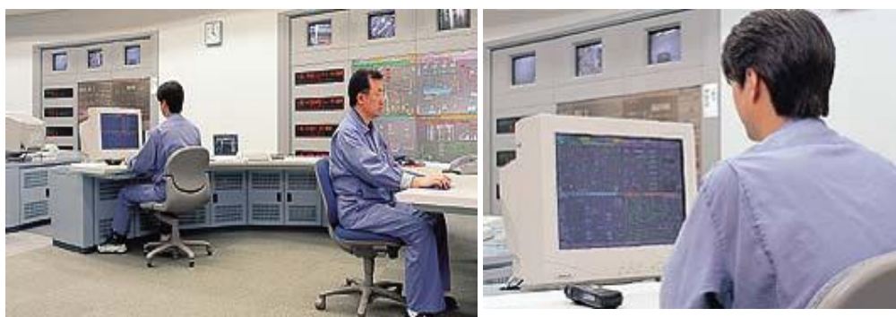
中控室設置相關流程板及 CRT 畫面進行運轉監視
