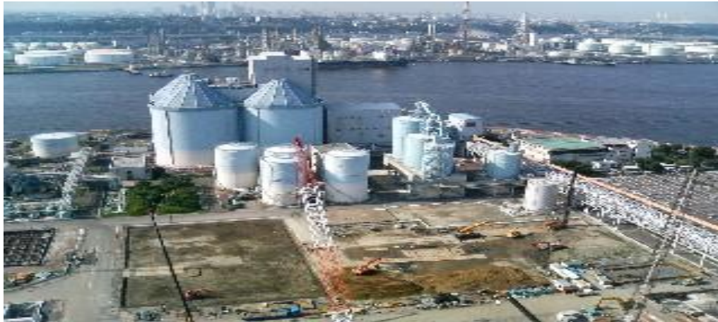
磯子火力發電廠 2 號機興建現狀
