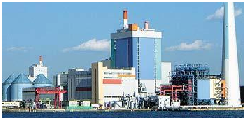
磯子火力發電廠新 1 號機外觀
