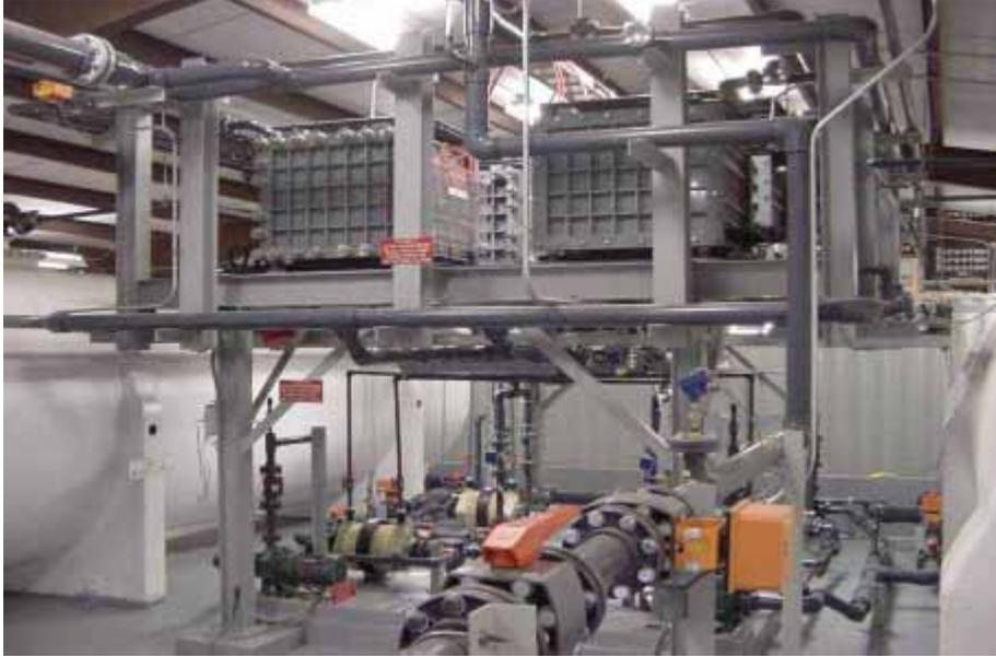
圖 24 Pacific Corp 裝設於 Moab 之 2MWh VRB 流動電池貯電系統
