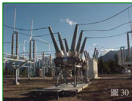
圖 29~30：聚合套管氣體斷路器
