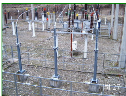
圖 25：瓷套管避雷器
