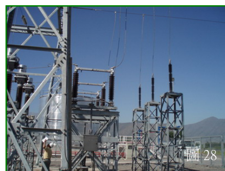
圖 26~28：聚合套管避雷器
