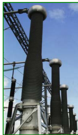
圖 32：聚合套管電纜頭
