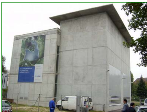
圖 1：Unterturkheim 變電所外
