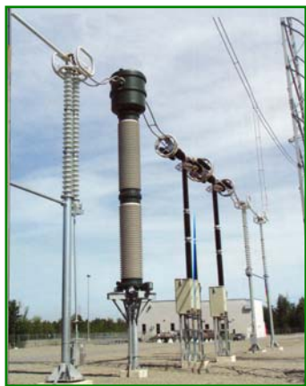
圖 31：聚合套管比壓器
