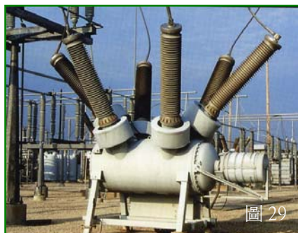
圖 29~30：聚合套管氣體斷路器
