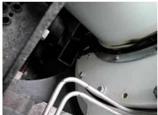
主軸承廢油收集槽需清潔處理
