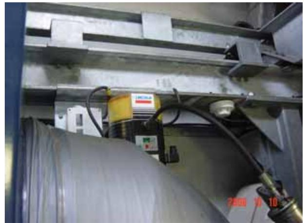
潤滑油注入發電機軸承貯油槽
