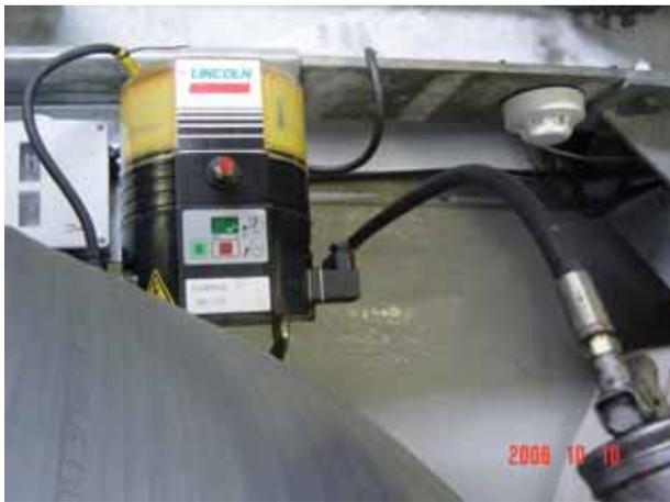
潤滑油直接注入發電機軸承
