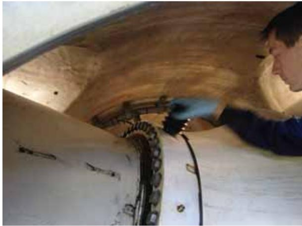
旋角軸承廢潤滑油收集罐拆卸
