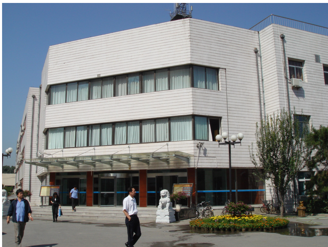
圖 6 北京第九水廠辦公大樓
