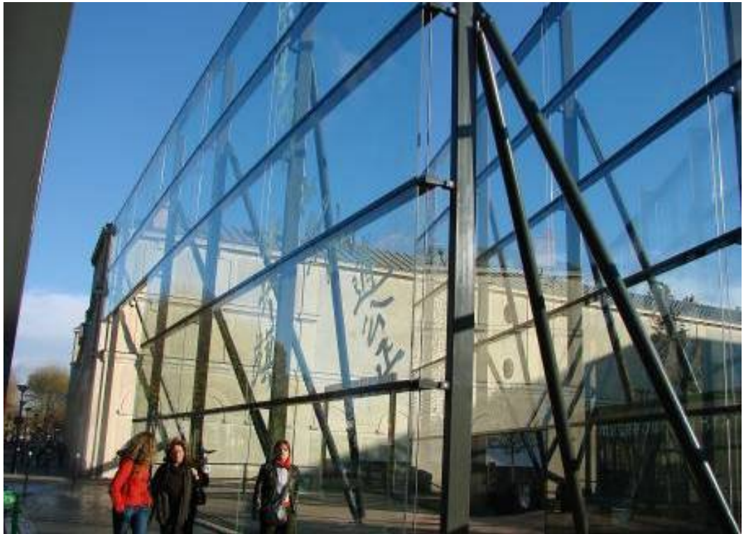
圖 2.利用鋼構及強化玻璃形成一道透明帷幕
