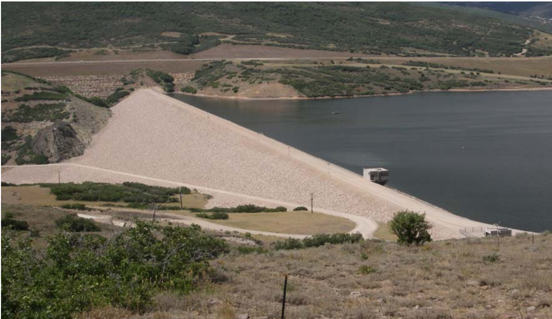
照片 6 JORDENELLE DAM 俯視圖
