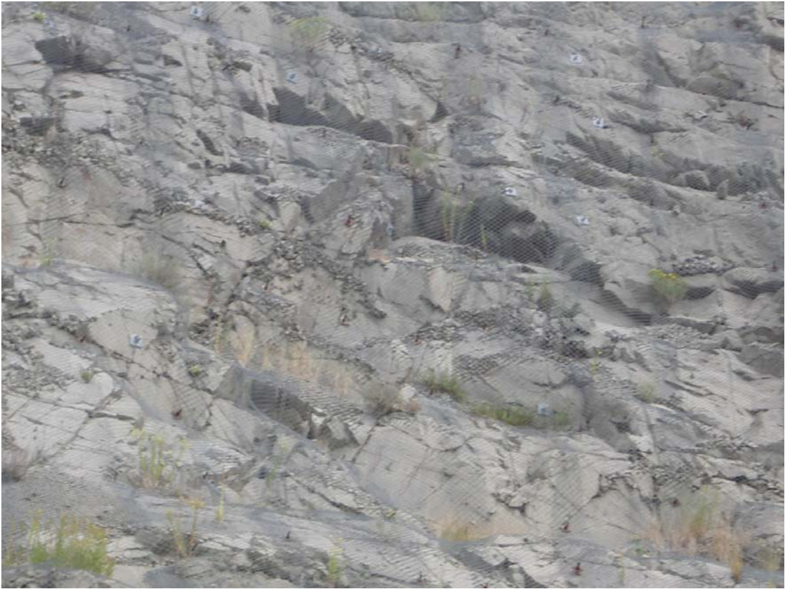
照片 10 JORDENELLE DAM 邊坡保護
