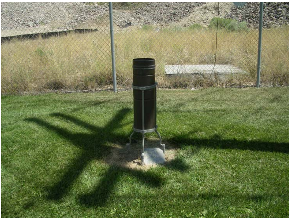
照片 19 DEER CREEK DAM 雨量計
