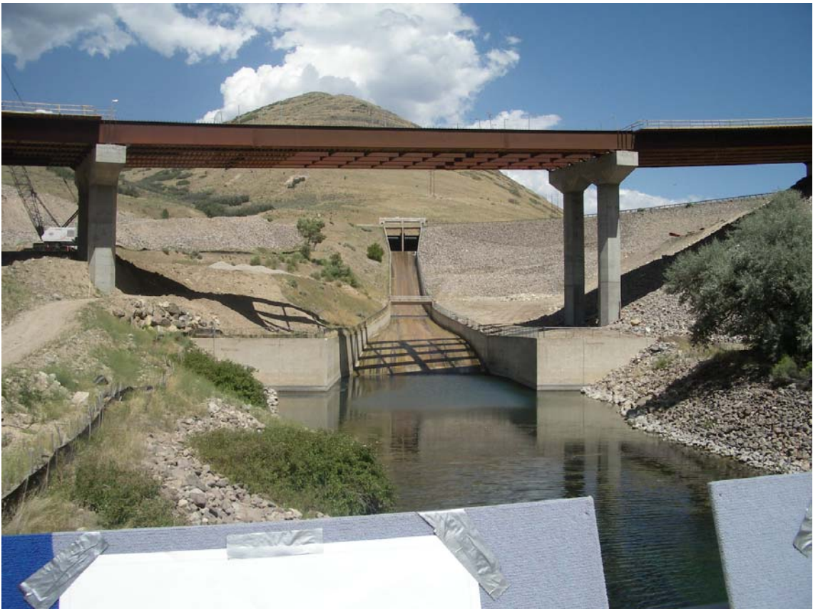
照片 15 DEER CREEK DAM 溢洪道
