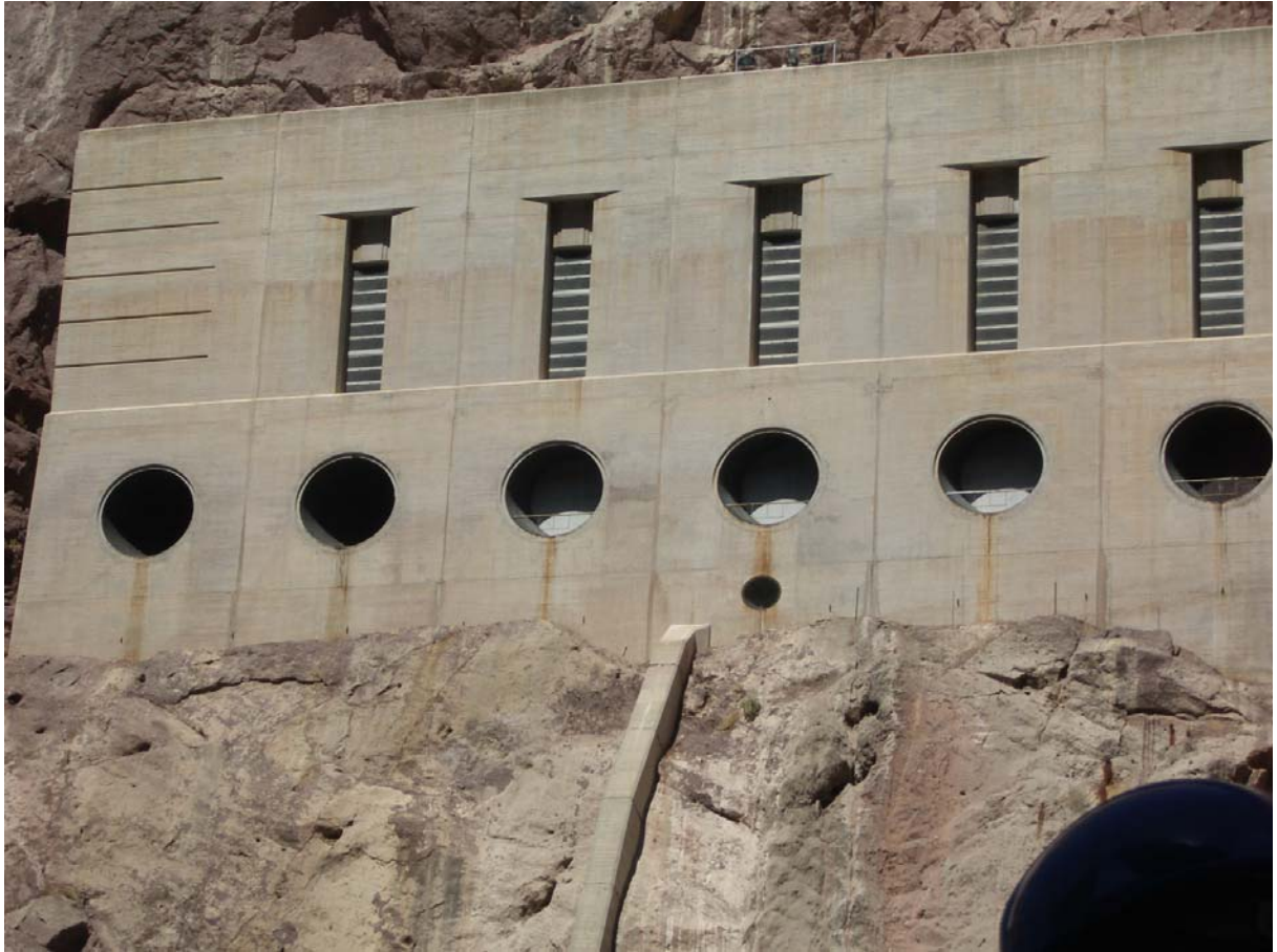
照片 31 HOOVER DAM 出水工
