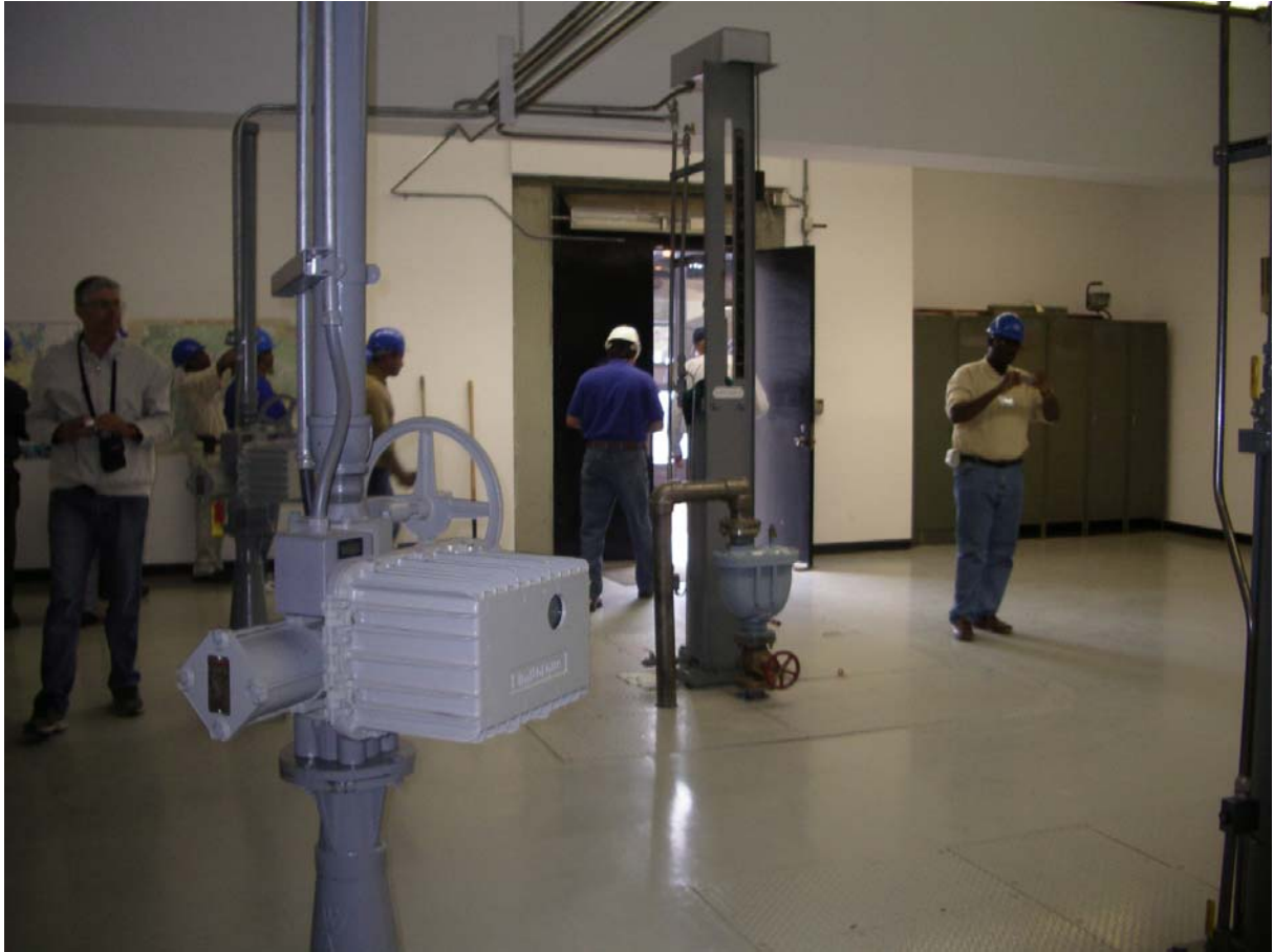
照片 27 UPPER STILLWATER DAM 出水閘門控制室
