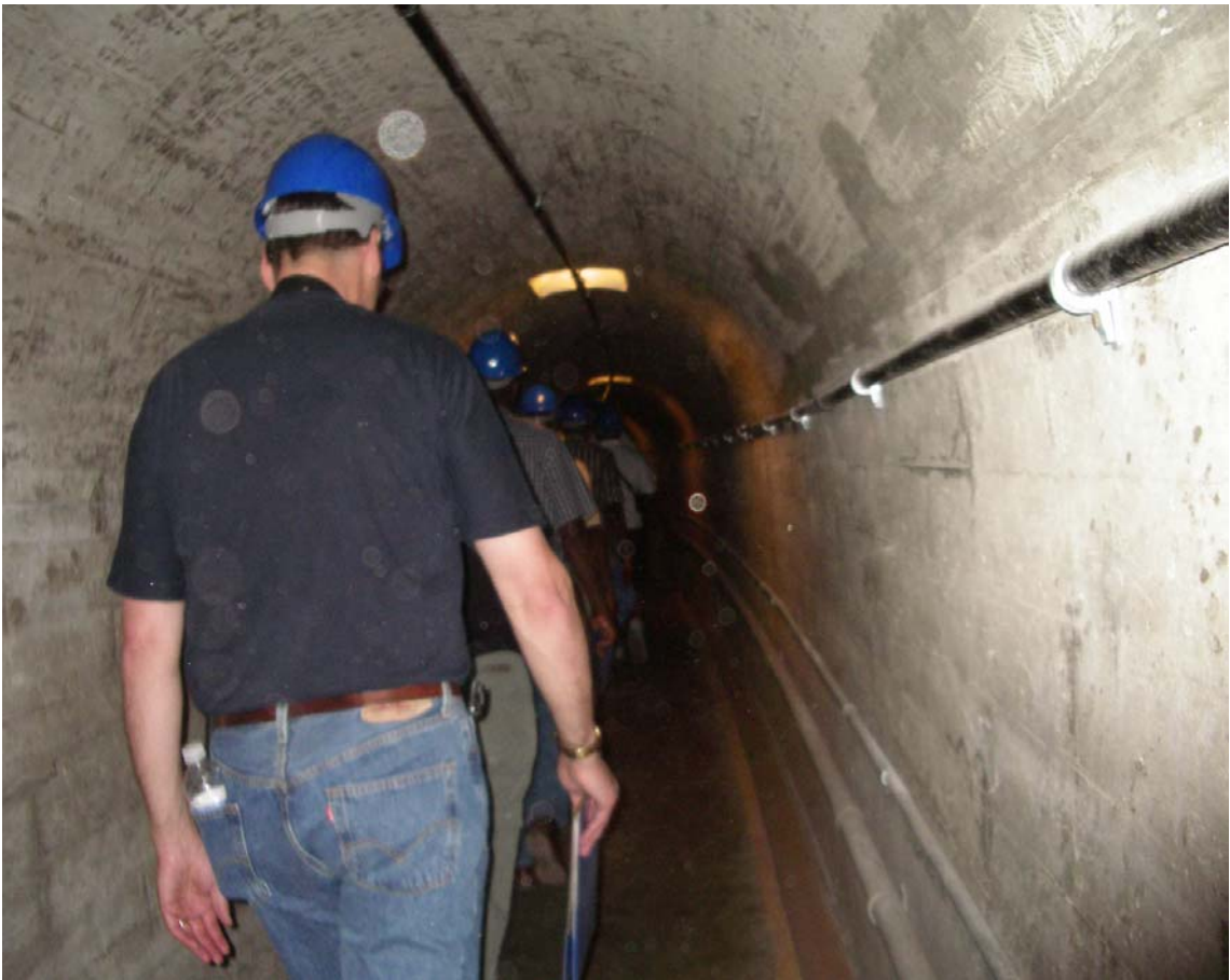
照片 34 HOOVER DAM 廊道檢查
