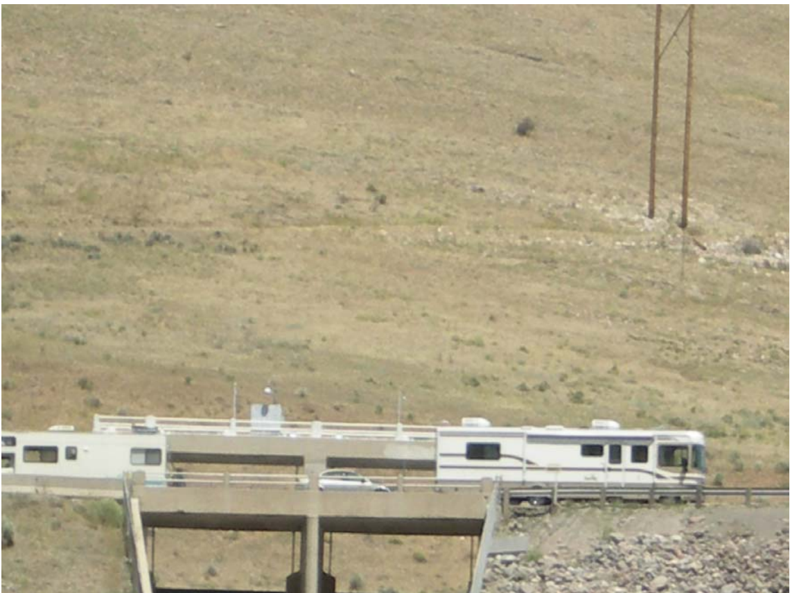
照片 13 DEER CREEK DAM 溢洪道
