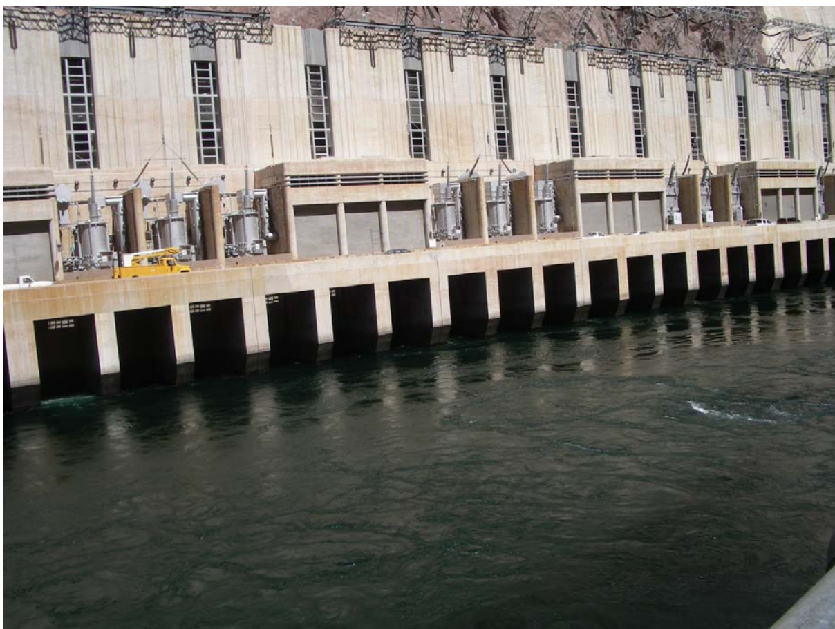
照片 29 HOOVER DAM 出水工
