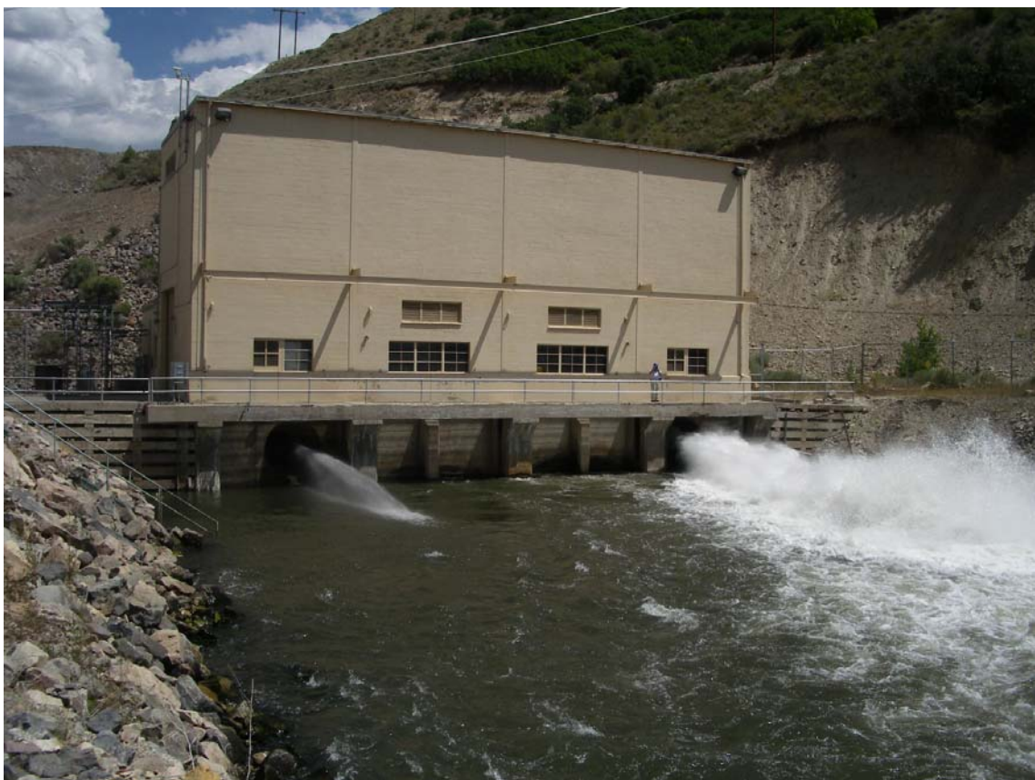
照片 17 DEER CREEK DAM 出水工
