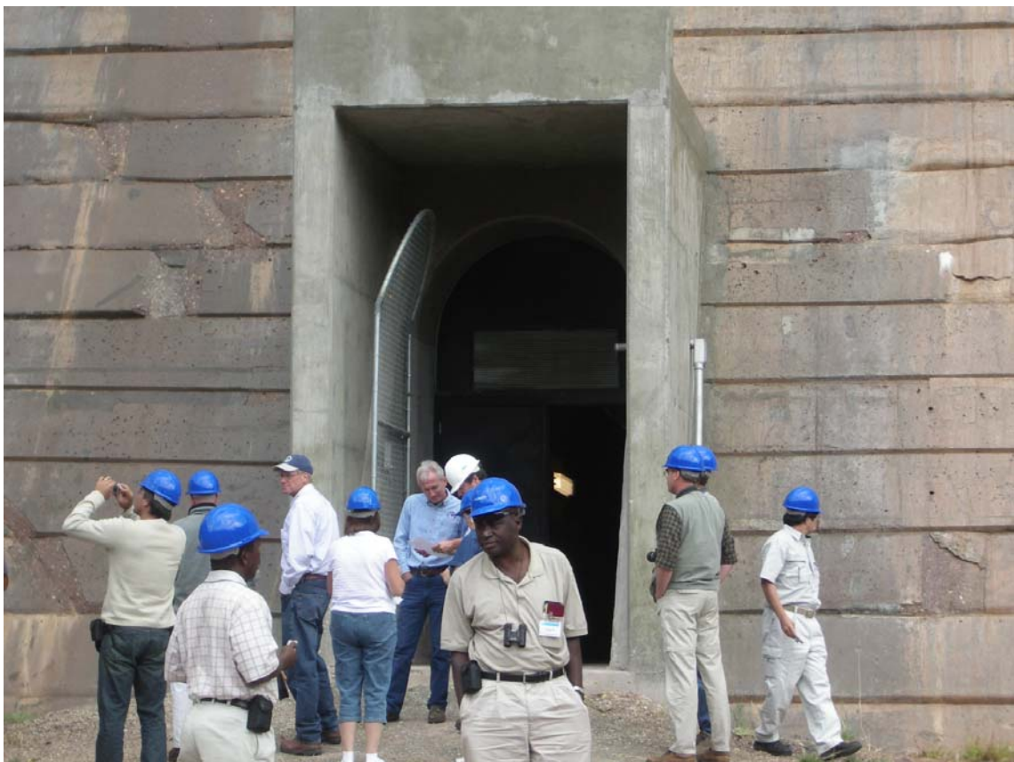
照片 24 UPPER STILLWATER DAM 廊道入口
