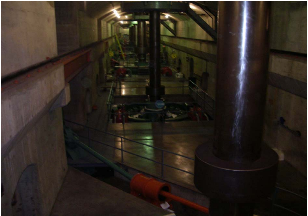
照片 32 HOOVER DAM 發電機渦輪
