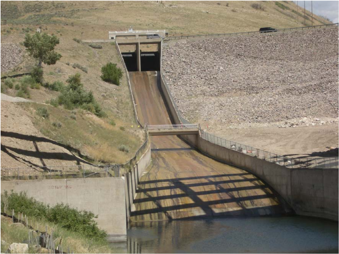
照片 14 DEER CREEK DAM 溢洪道
