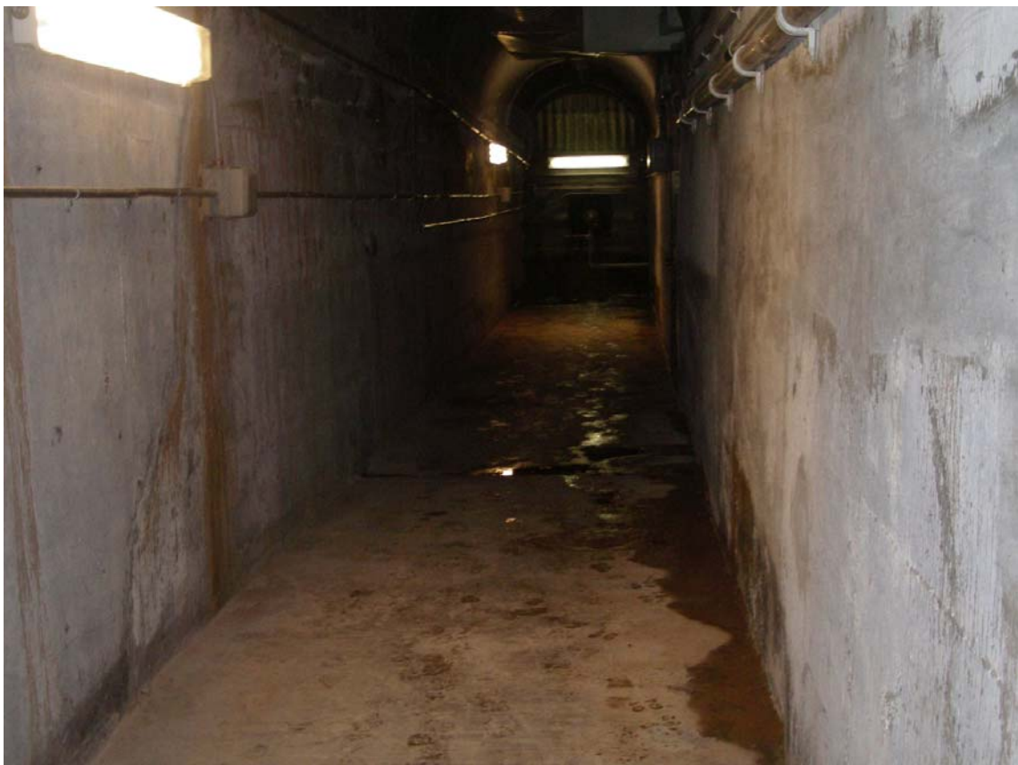
照片 26UPPER STILLWATER DAM 廊道內部
