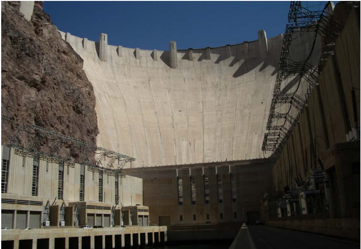
照片 28 HOOVER DAM 正視圖
