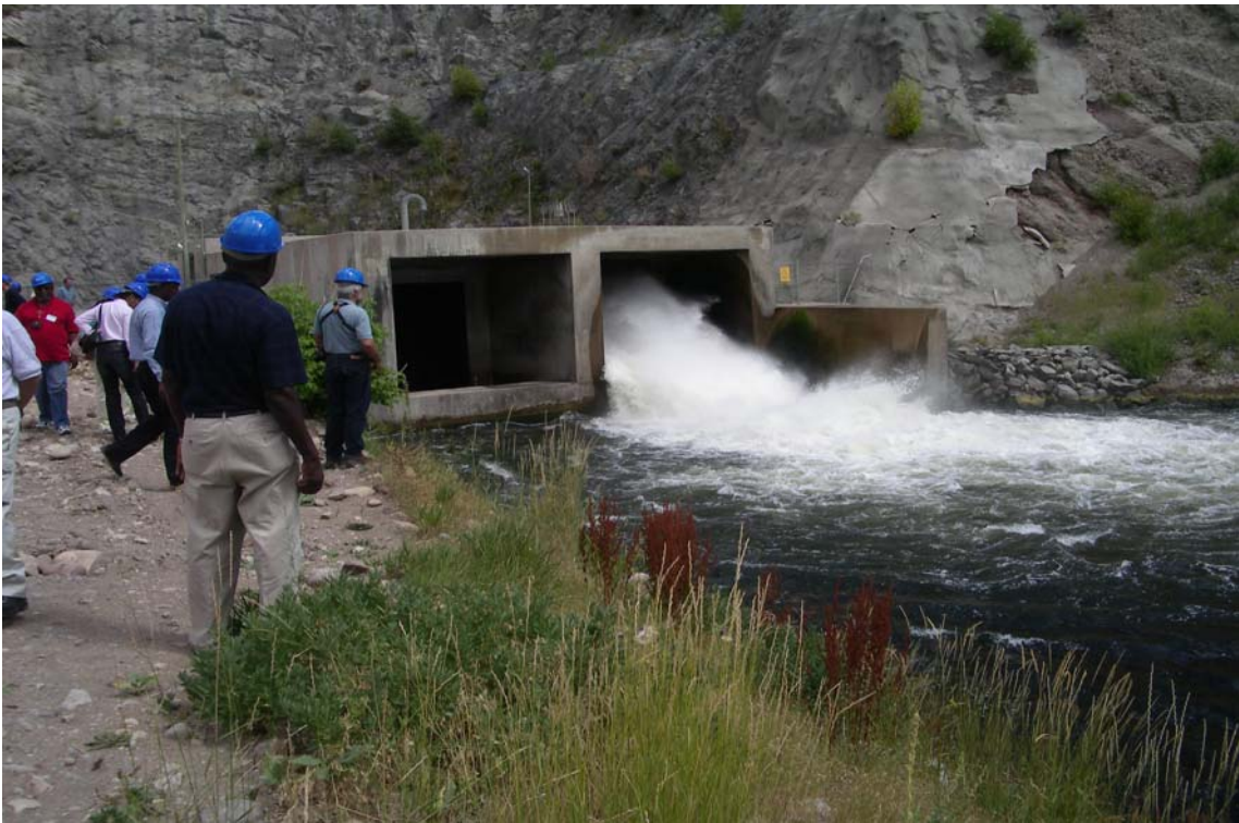
照片 7 JORDENELLE DAM 出水工
