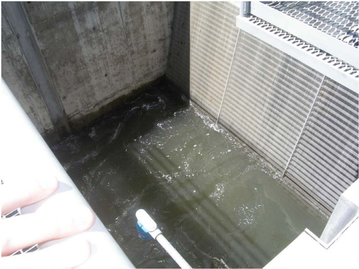
照片 16 DEER CREEK DAM 取水工攔污閘門
