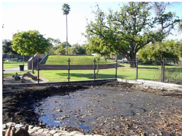
已挖掘完畢回填的 9 號坑。
