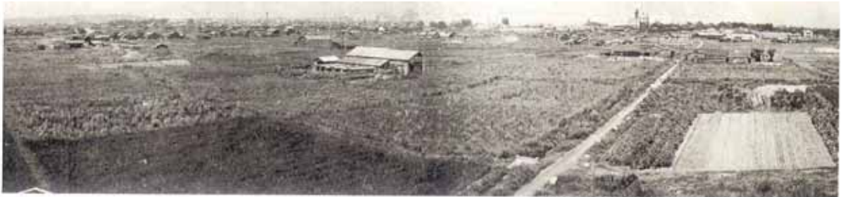
工事着工前の事業区域内風景（昭和35年7月6日）
