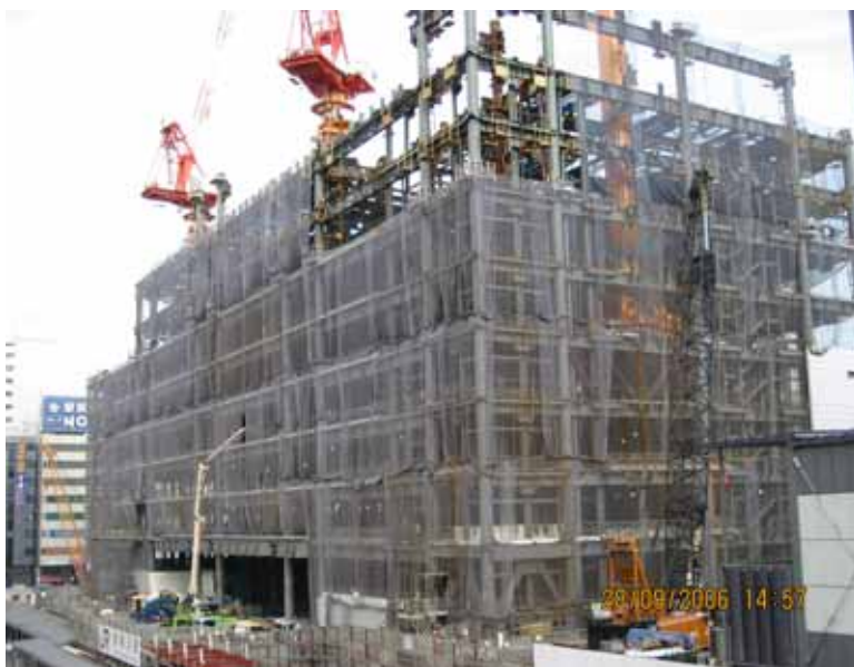
改建施工中的新橫濱車站
