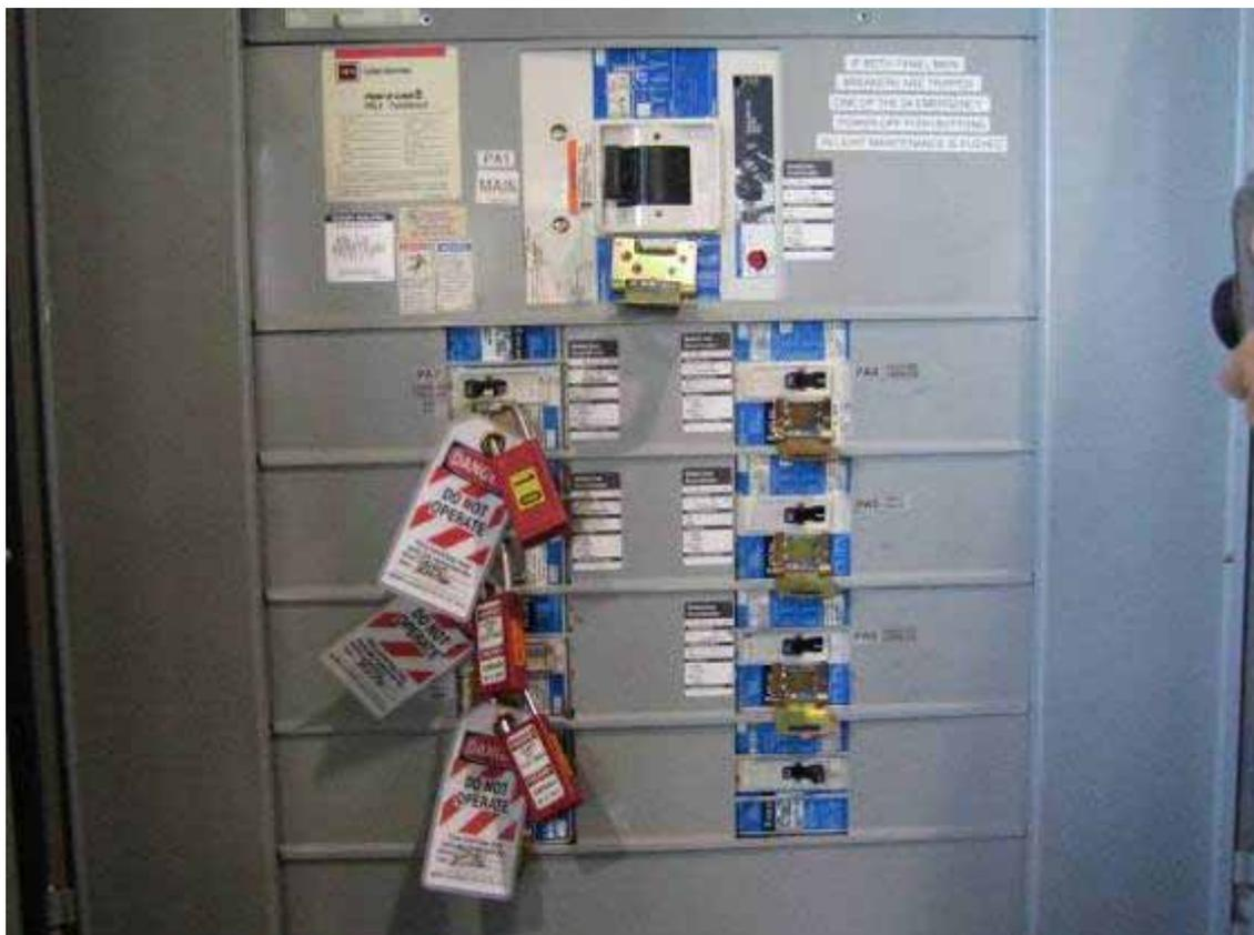
圖 3.2-11 舊金山 AIRTRAIN 維修人員施工時每人皆須每人掛掛鎖以防止感電事件
