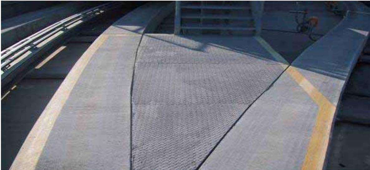
圖 3.2-16 舊金山 AIRTRAIN 維修人員於軌道行走時之防滑鋼板
