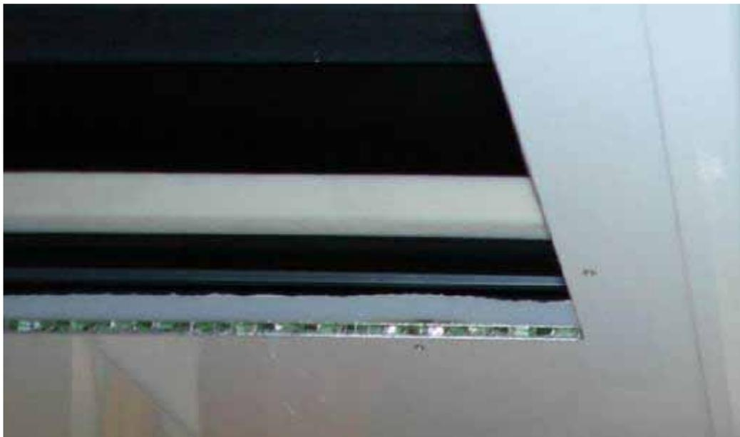
圖 2.4-16 蜂巢狀鋁合金結構板
