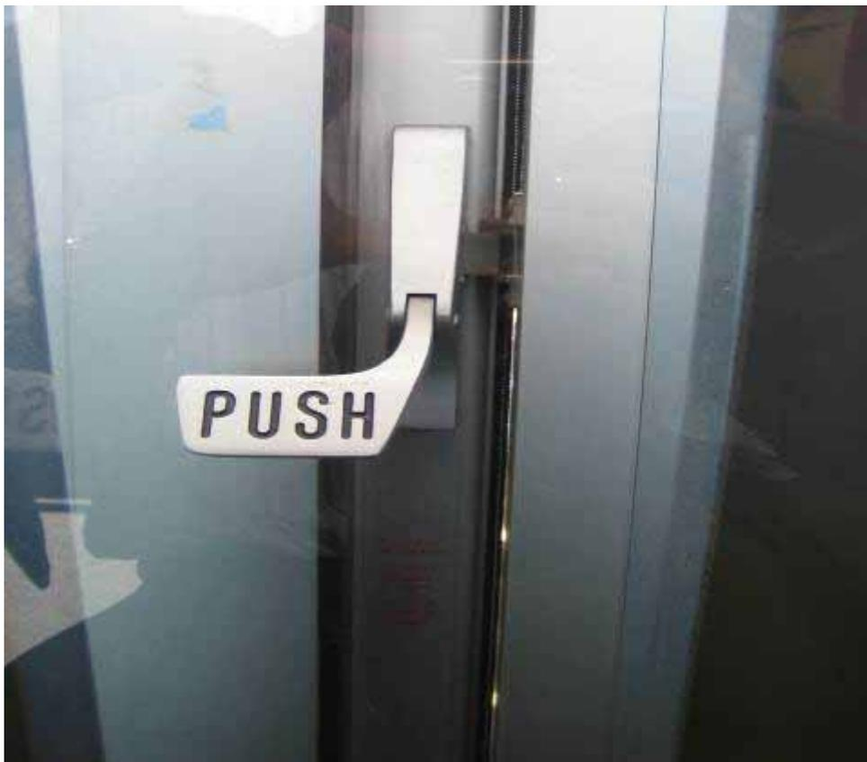
圖 3.2-8 舊金山 AIRTRAIN 車站月台的緊急門開啓把手
