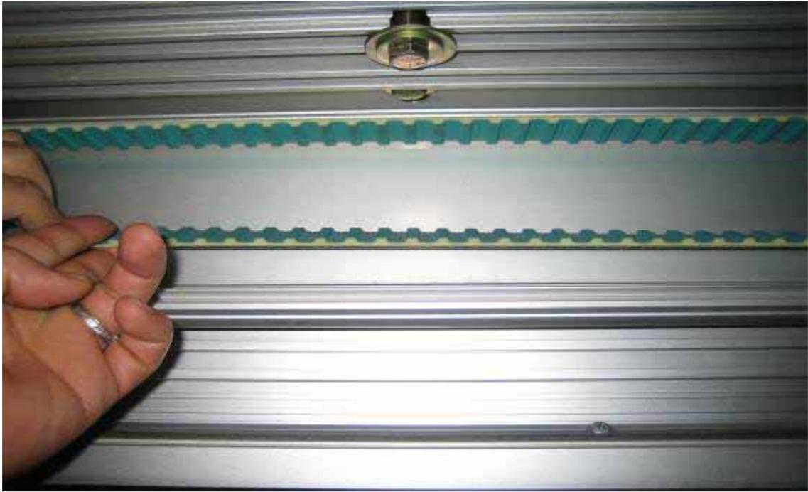
圖 3.2-7 舊金山 AIRTRAIN 月台門鏈帶傳動裝置
