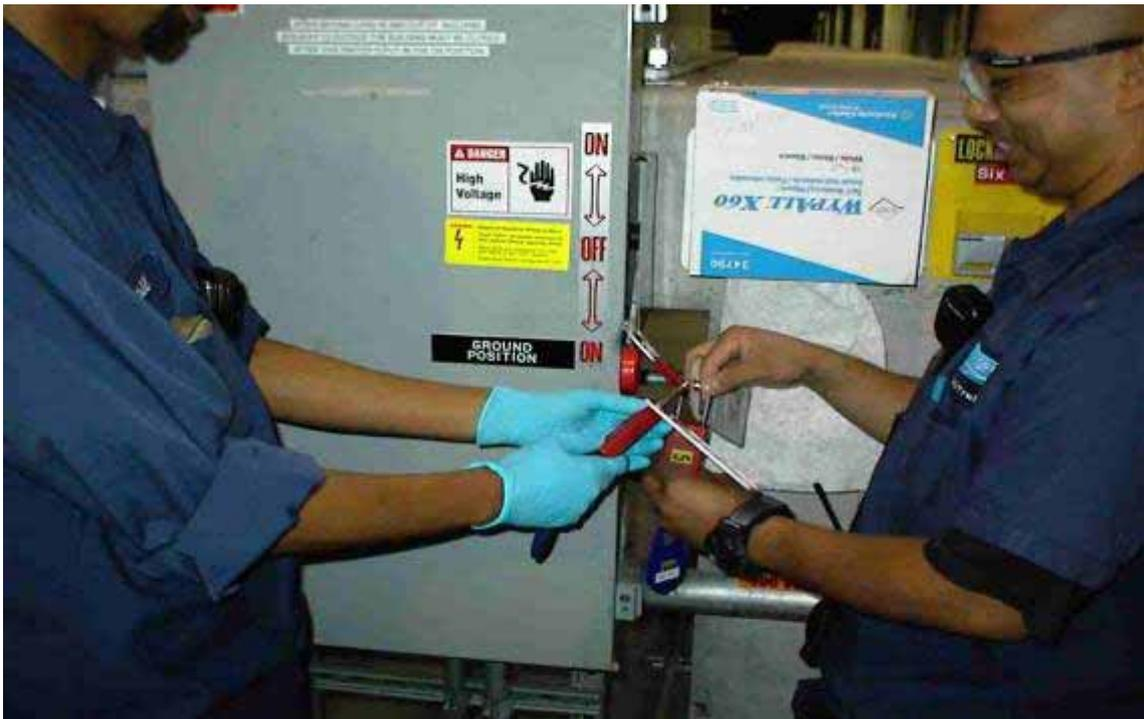
圖 3.2-10 舊金山 AIRTRAIN 維修人員施工前掛掛鎖以確保安全
