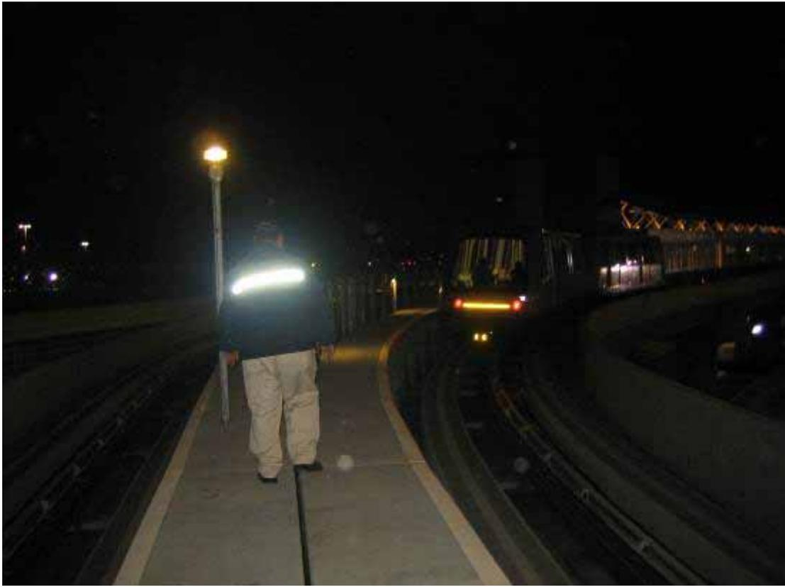
圖 3.2-14 舊金山 AIRTRAIN 軌道中之寬大的中央走道
