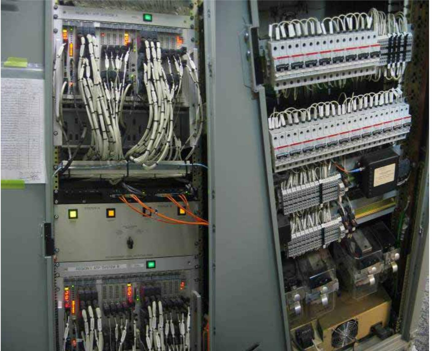
圖 3.2-1 舊金山 AIRTRAIN 行控中心道旁控制設備 ATP
