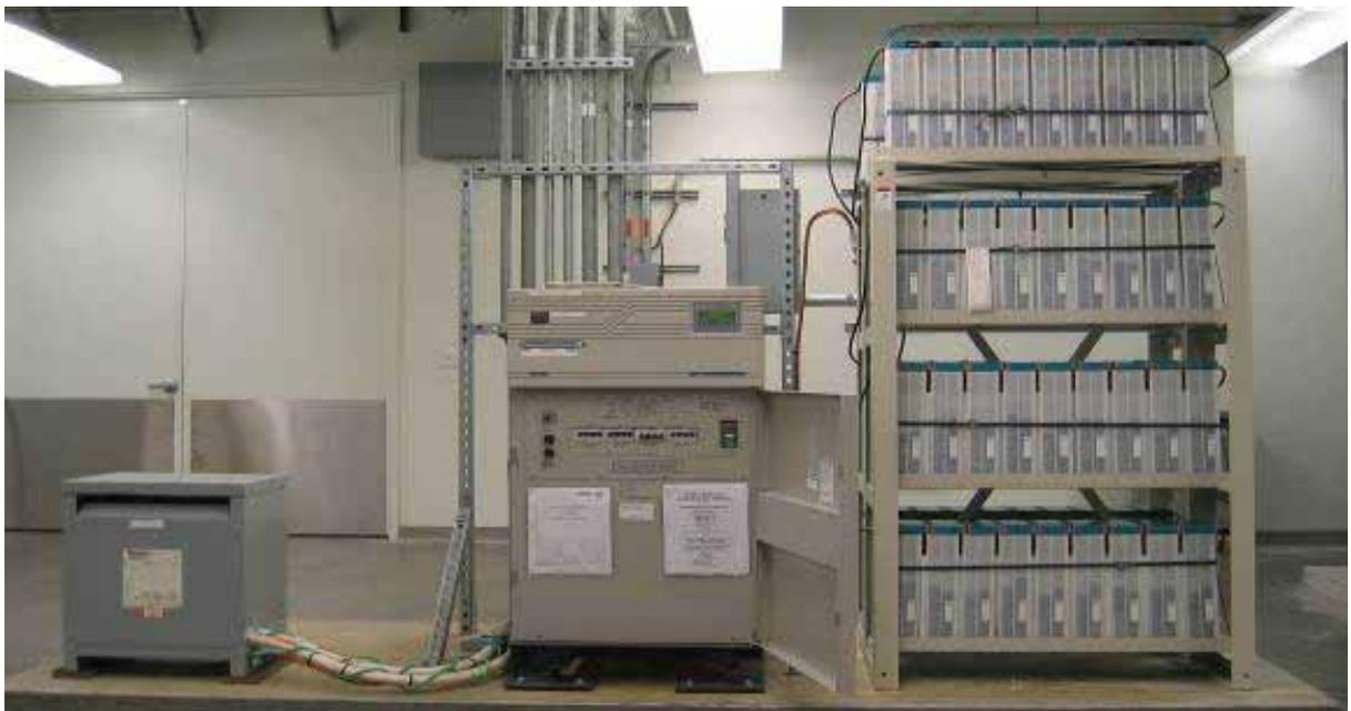
圖 3.1-4 舊金山 AIRTRAIN 行控中心電腦室不斷電系統 UPS
