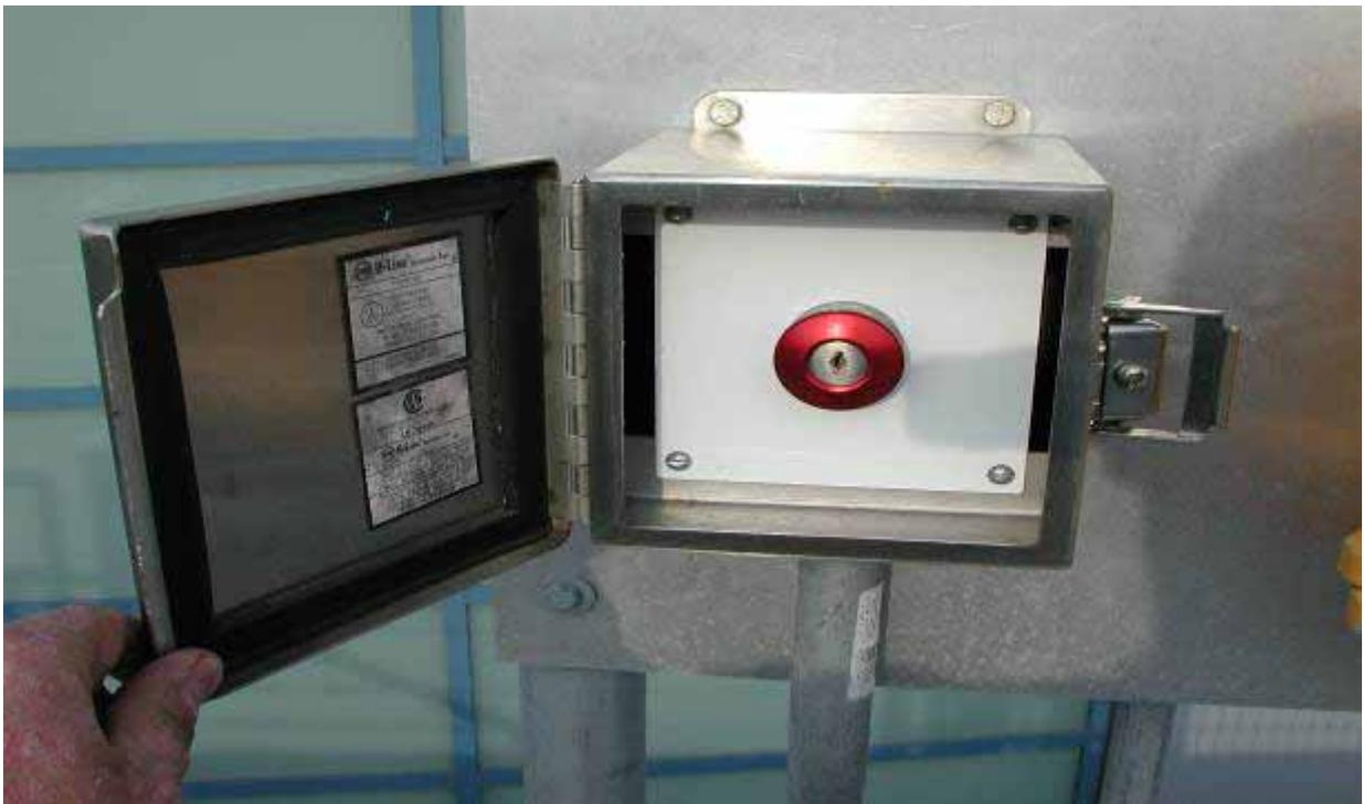
圖 3.2-13 舊金山 AIRTRAIN 軌道旁之緊急斷路器
