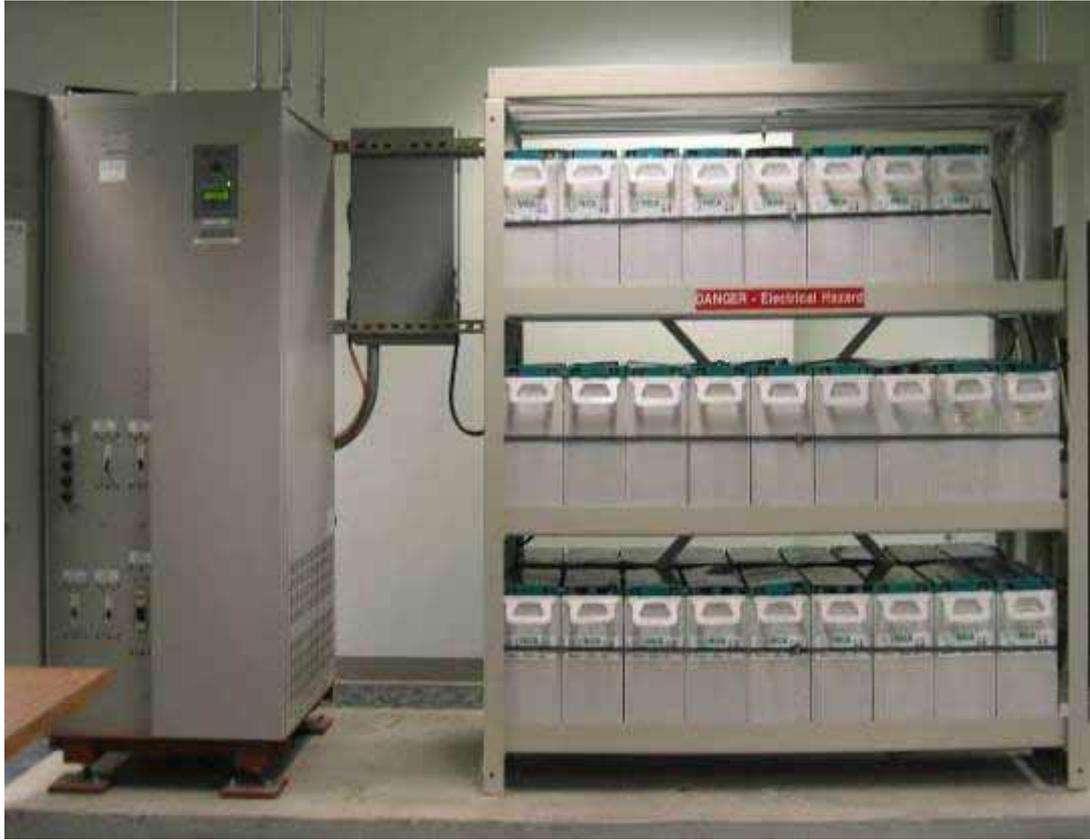
圖 3.1-3 舊金山 AIRTRAIN 行控中心電腦室不斷電系統 UPS
