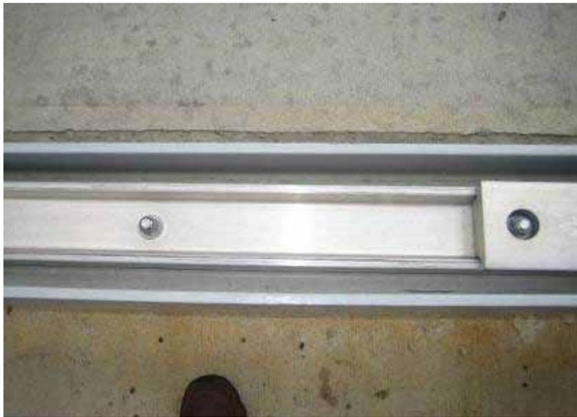
圖 4.2-9 電軌鋼構溝槽內輔以長條型鋁塊
