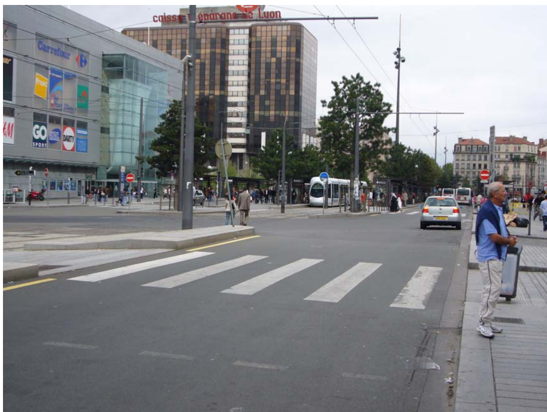
法國里昂道路布設。【1-9】
