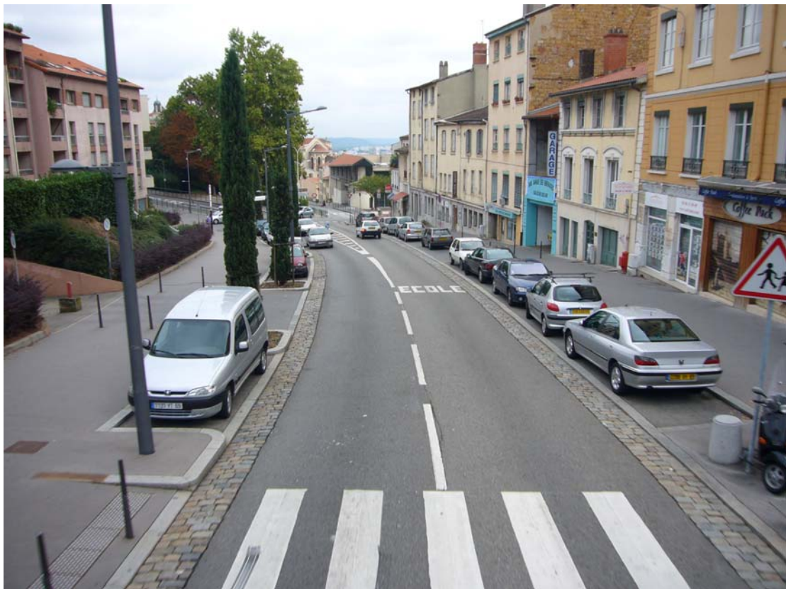
法國里昂道路車道、停車格及人行道。【1-12】
