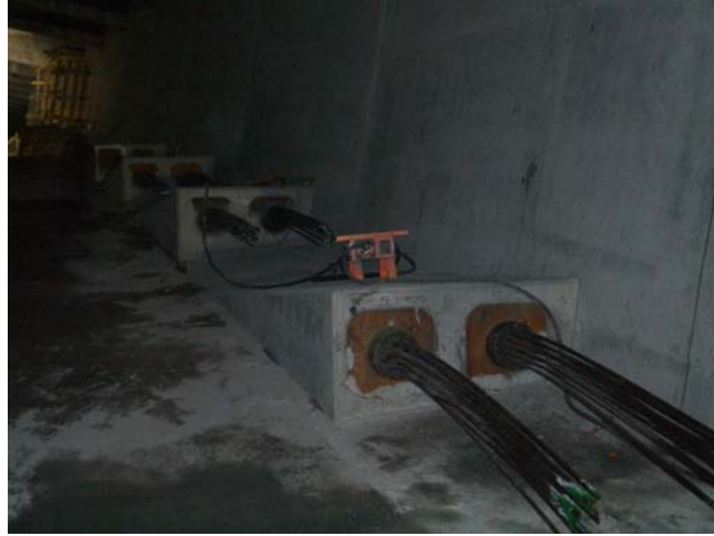
圖 9 預力箱型梁之後拉鋼絞線
