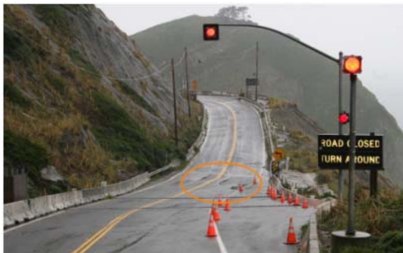
圖 2 魔鬼坡 2005 年災損情形
