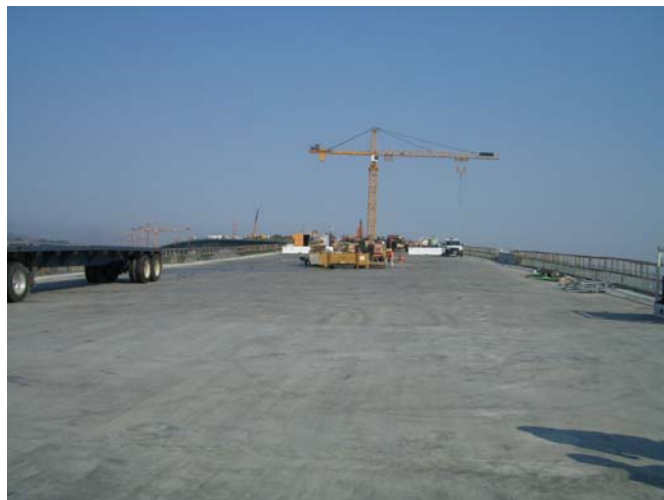
圖 5 已完成之引道
