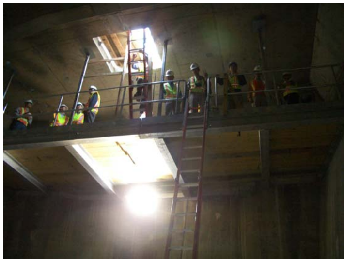
圖 7 本團進入預力箱型梁內部參觀
