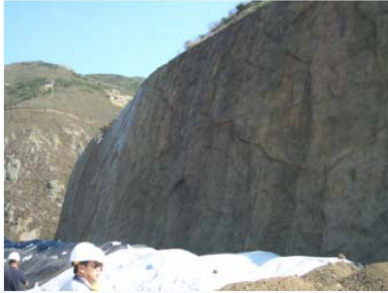
圖 4 魔鬼坡噴漿護坡上漆後之情形
