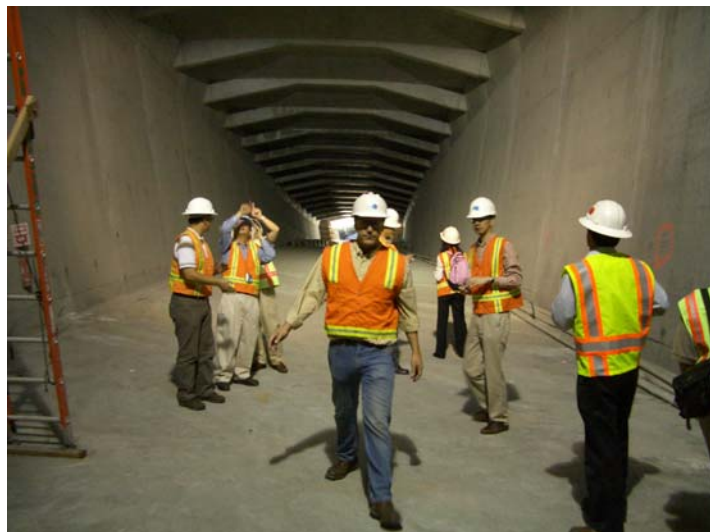
圖 8 本團進入預力箱型梁內部參觀
