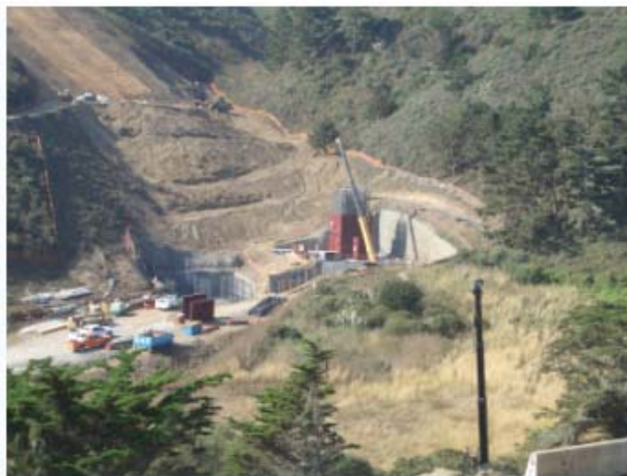
圖 5 北洞口施工情形
