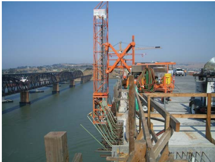
圖 13 施工中之工作車
