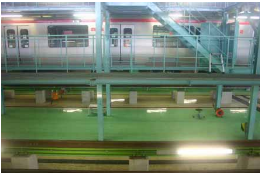
相片 19 檢修平台
