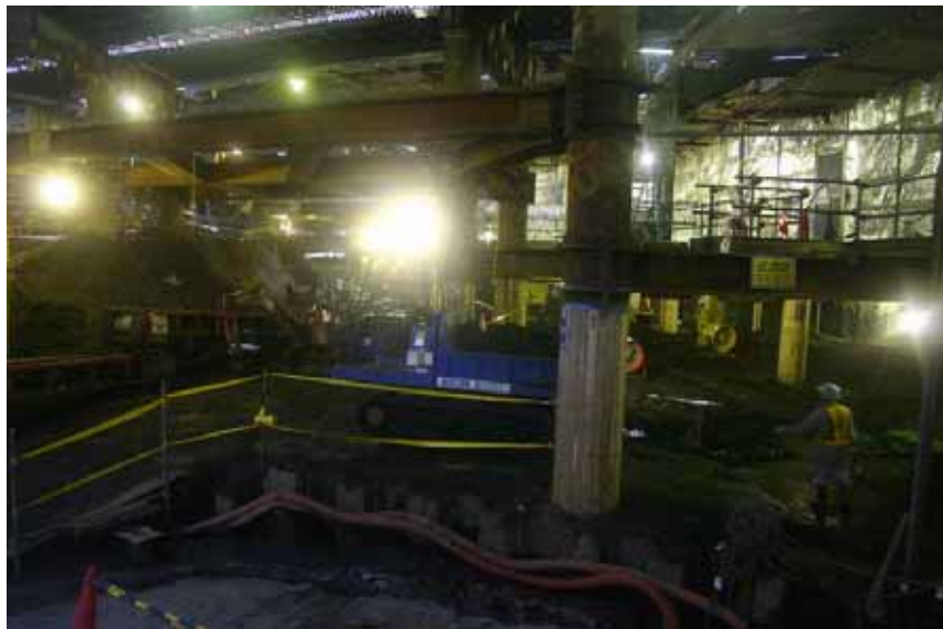
相片 03 橫濱車站地下擴建工程
