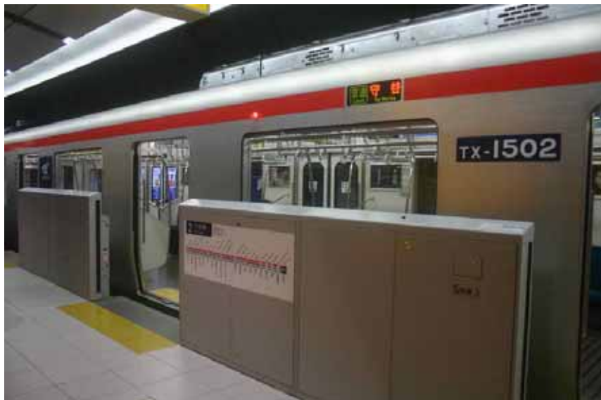
相片 27 月台邊緣閘門
