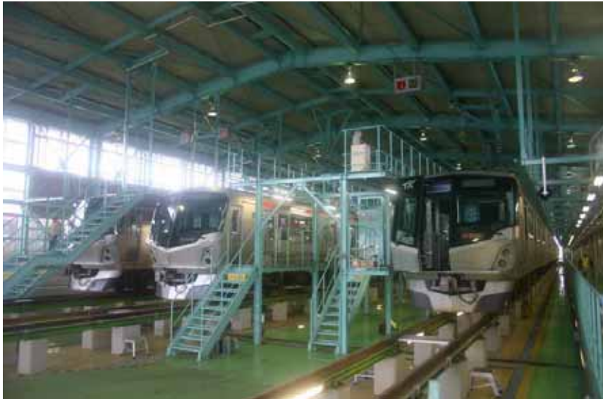
相片 21 檢修車庫
