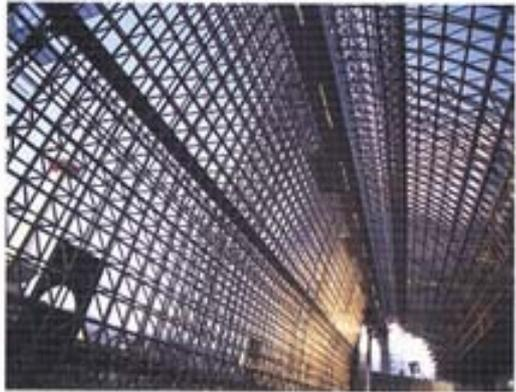
アトリウム：幅29m、長さ147m、4000枚のガラスに覆われ空と溶け込む空間
