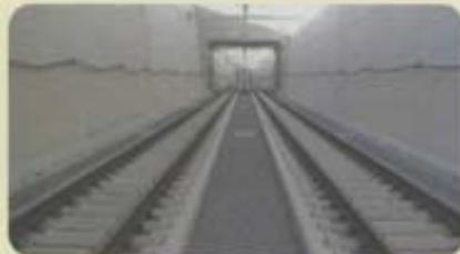
● **弾性マクラギ直結軌道(バラスト散布型)**
