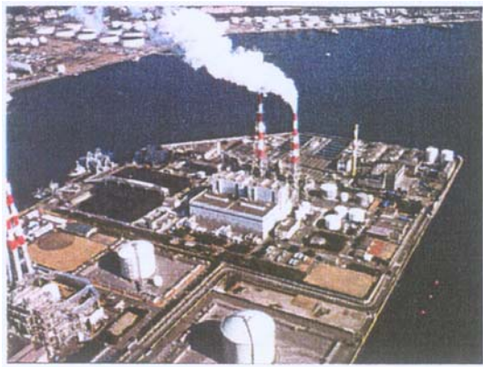
圖 1 磯子發電廠改建前外觀
