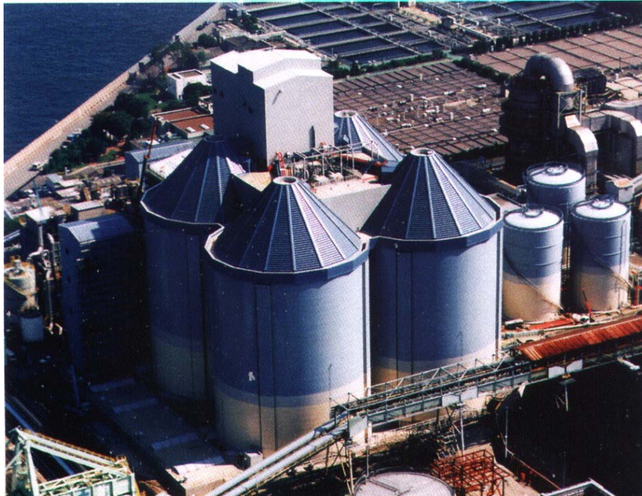
圖 8 礪子火力發電廠苜宿型室內煤倉 (資料來源：日本礪子火力發電廠解說摺頁簡介)
