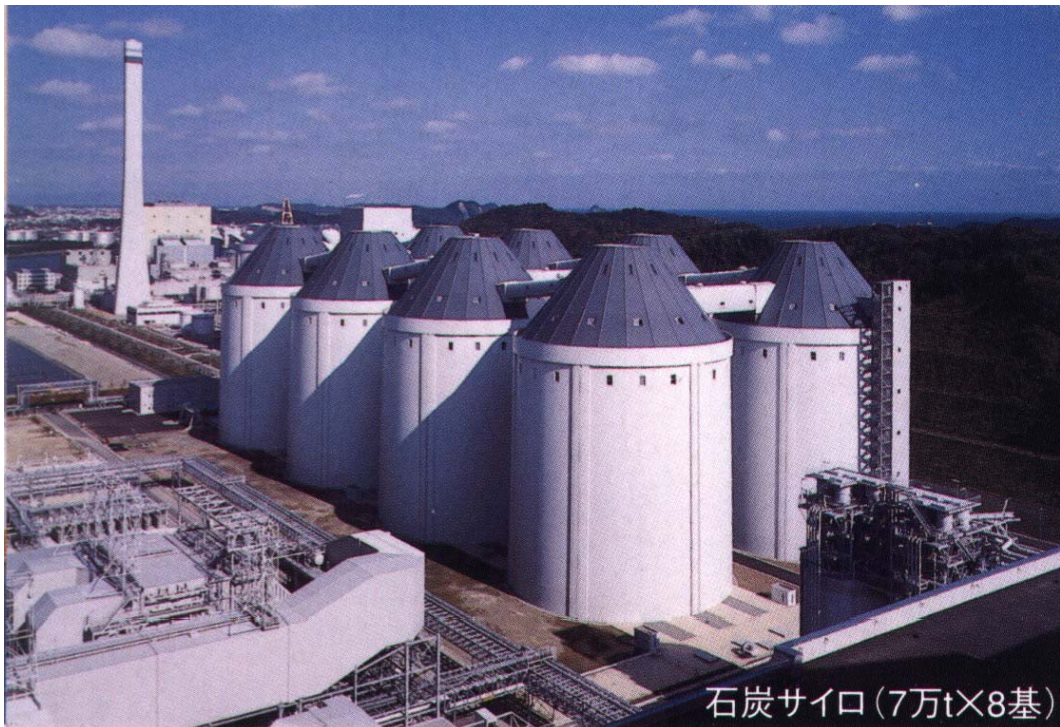
圖 15 橘灣火力發電廠煤倉 (資料來源：日本橘灣火力發電廠解說摺頁簡介)
