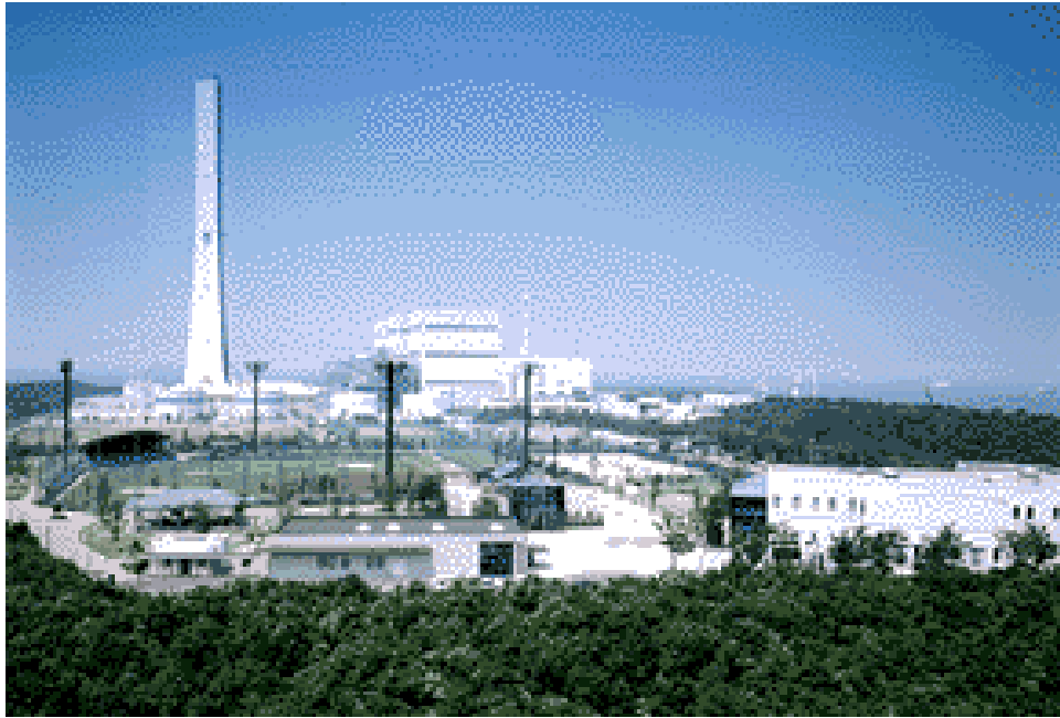
圖 21 南港火力發電廠外觀 (資料來源： http://www.kepco.co.jp )
