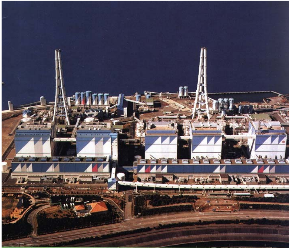
圖 17 碧南火力發電廠外觀－悠游三河灣的白帆 (資料來源：日本碧南火力發電廠解說摺頁簡介)
