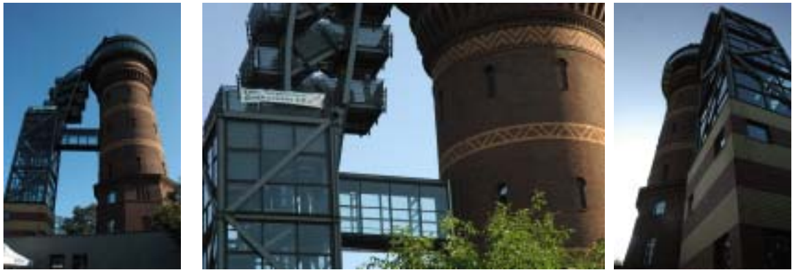
水塔外觀，左側樓梯與升降梯為新設方便遊客至塔頂攬勝。
