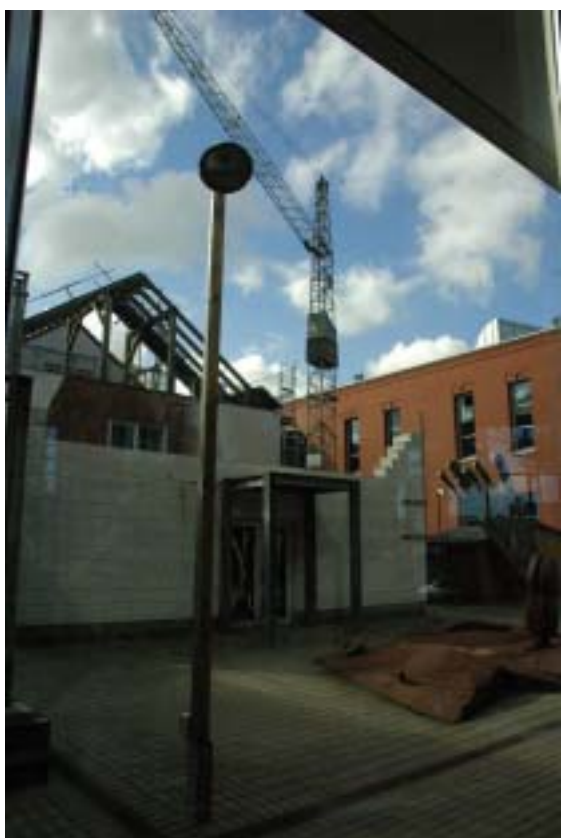
DASA 的中庭營造成建築工地，示範工地的安全措施
