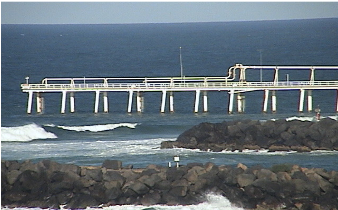
Brisbane 離岸抽砂設備
