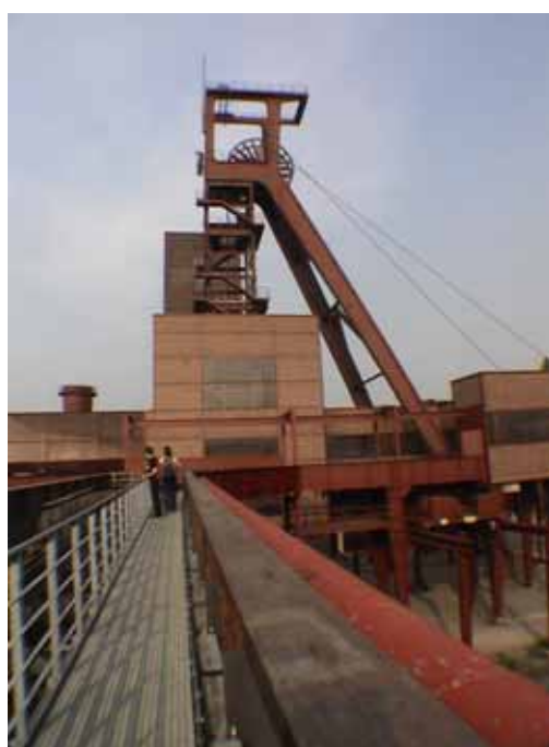
關稅同盟十二號礦區—運煤輸送塔
