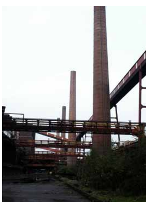
關稅同盟十二號礦區—保存完整的管線叢林
