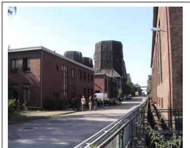
園區環境--舊廠區再利用與設施保存
