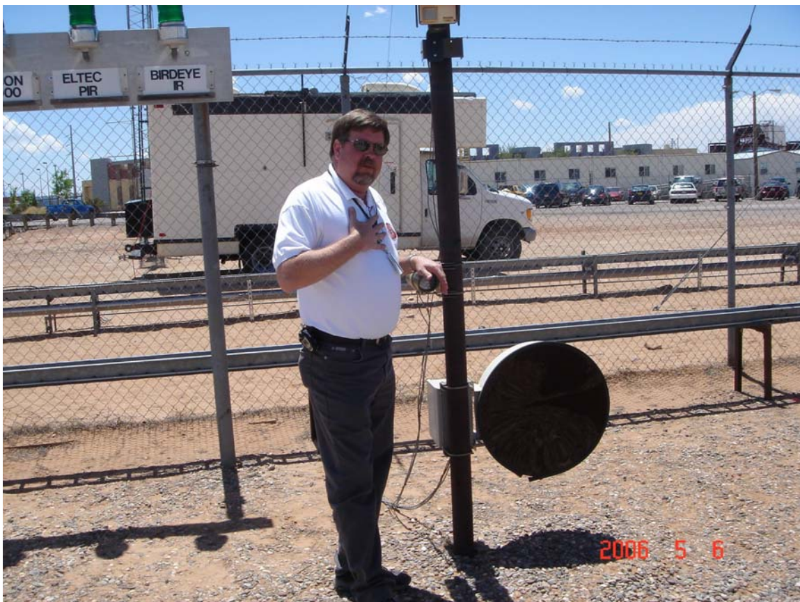
圖三、實地測試教學 (外部入侵偵測器)
