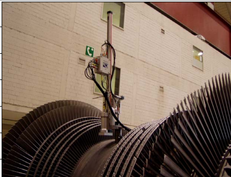
圖 23：為 Siemens Power Generation 公司對 LP Turbine 轉子作 Radial Bore Inspection。
