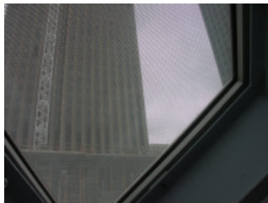
玻璃上的細網，減少陽光透射量
