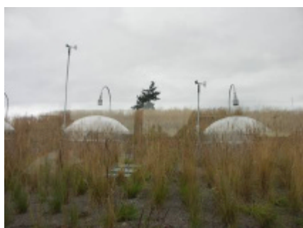
從觀景台觀看 Ballard 分館綠屋頂
