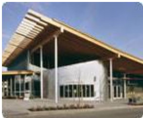
Ballard 分館(改建) 2005/5/4 重新開館
