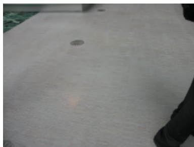
由分館拆除之廢料所鋪設的地板
