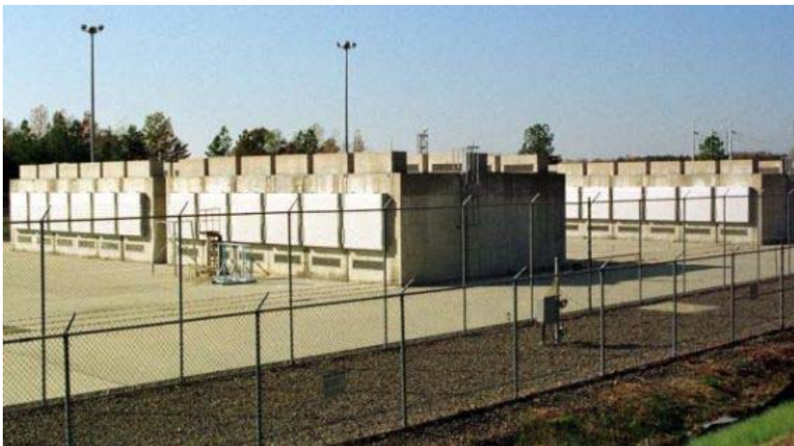
圖二 卡佛特克利夫斯核能電廠用過核燃料中期貯存場貯存作業照片
