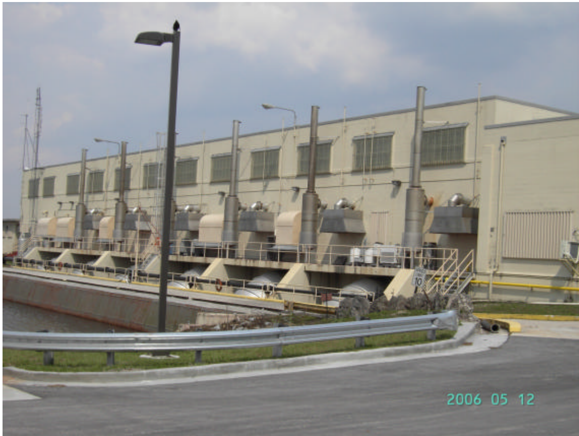
圖4-6 抽水機控制室
