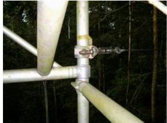
3 座高塔上約 30 公尺處，以橋面連接成三角形通道。其卡榫連接確實。
