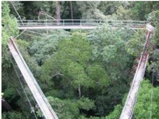
3 座高塔上約 30 公尺處，以橋面連接成三角形通道。其卡榫連接確實。
