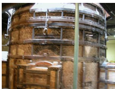
傳統倒焰式窯爐的一、二樓部分
