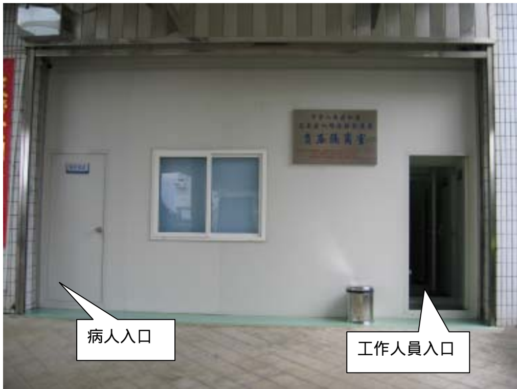
附圖 7 福州馬尾港「負壓隔離室」外觀
