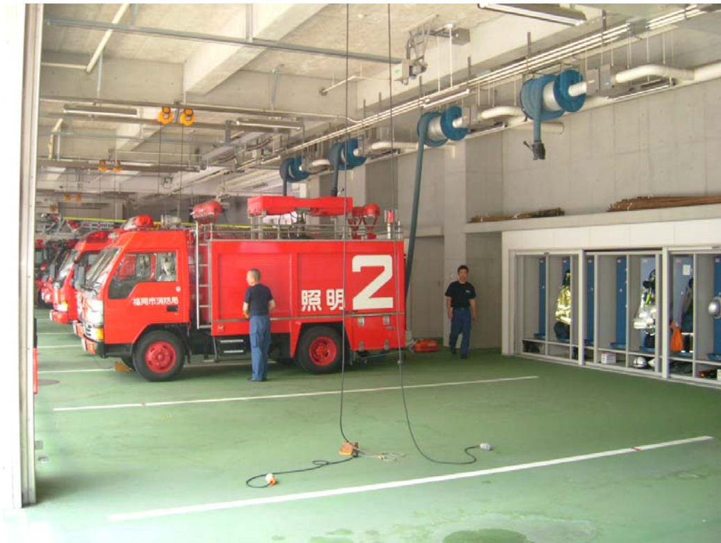
福岡市博多消防署車庫（上方藍色管線為加水裝置）
