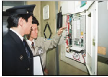
新建建築物檢查
