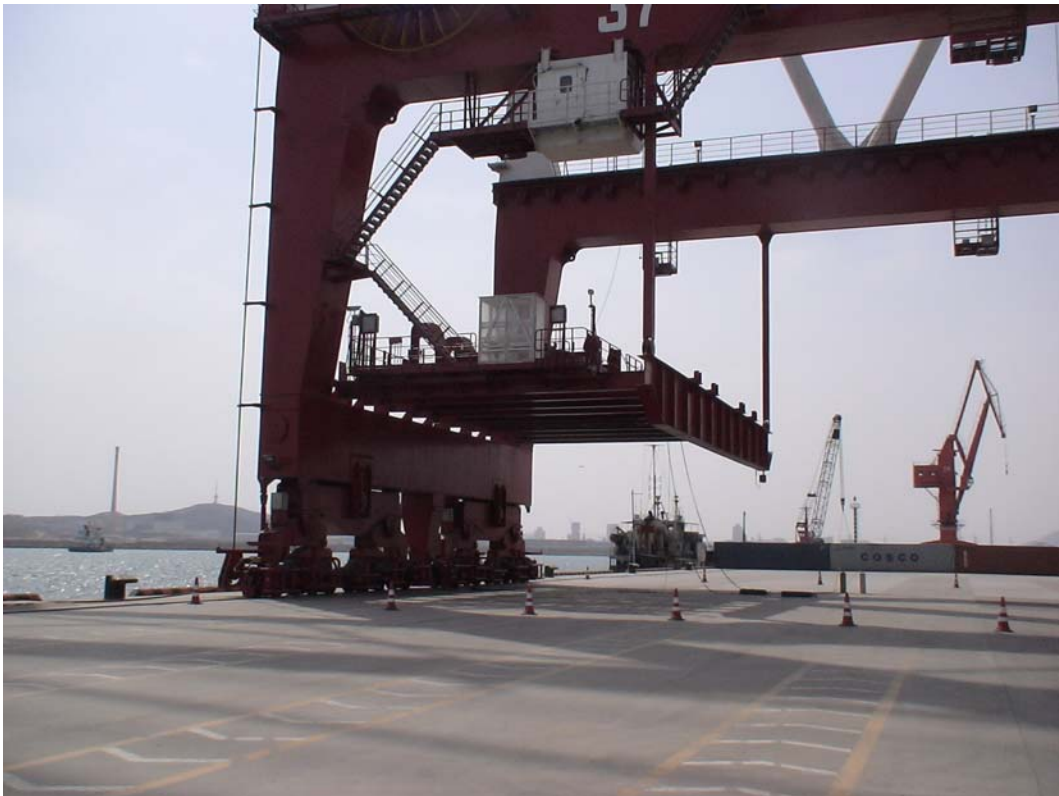
圖 40 青島港 100 噸橋式起重機貨櫃平台
