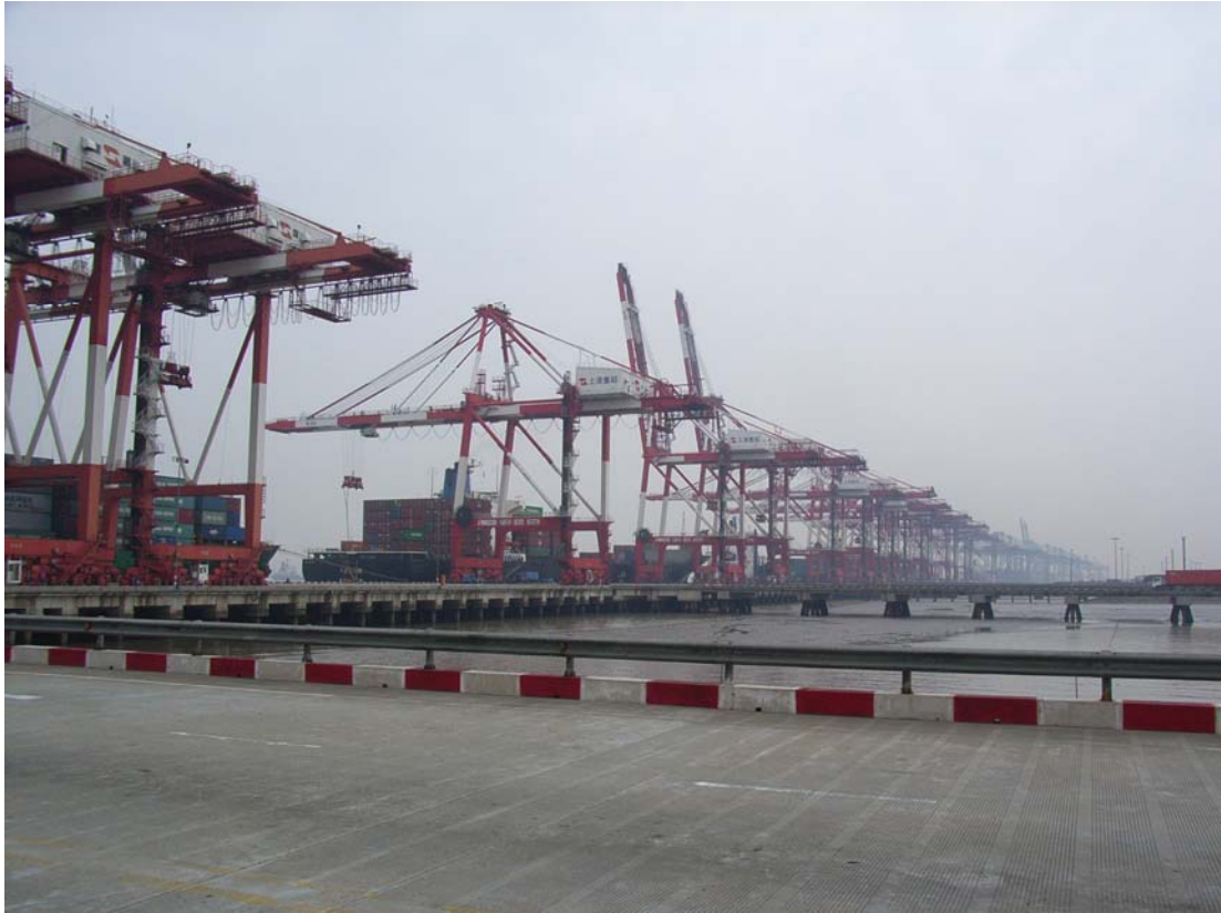
圖 17 上海港集集裝箱公司貨櫃碼頭採離岸堤構建及密集直線型橋式起重機之佈置
