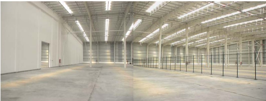
圖 43 青島港保稅物流園倉棧設施內部
