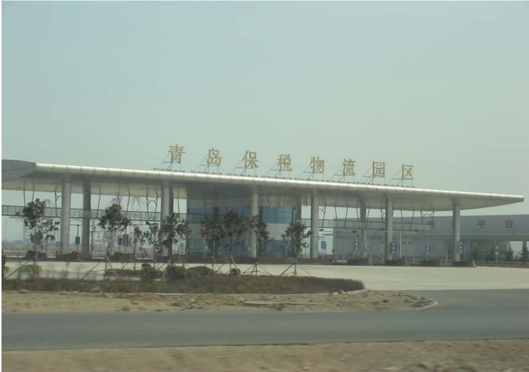
圖 42 青島港保稅物流園區大門
