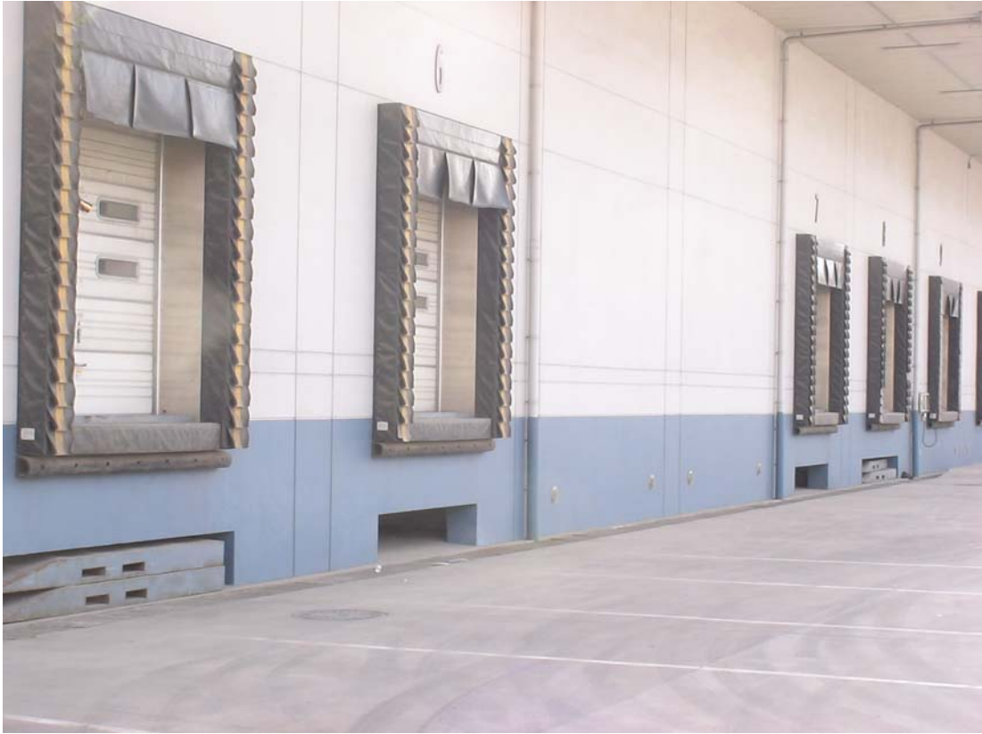
圖 53 山東愛通海豐公司冷凍倉儲氣密月台與自動升降門之設計
