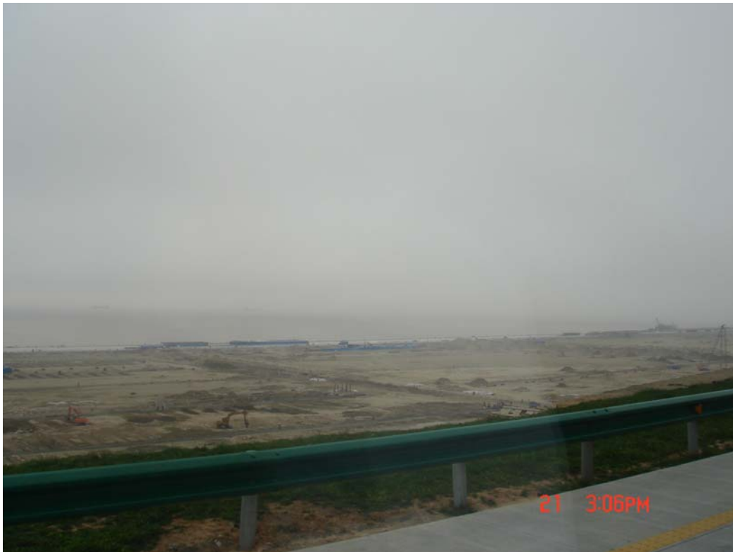
圖 27 洋山港二期貨櫃碼頭區建設鳥瞰
