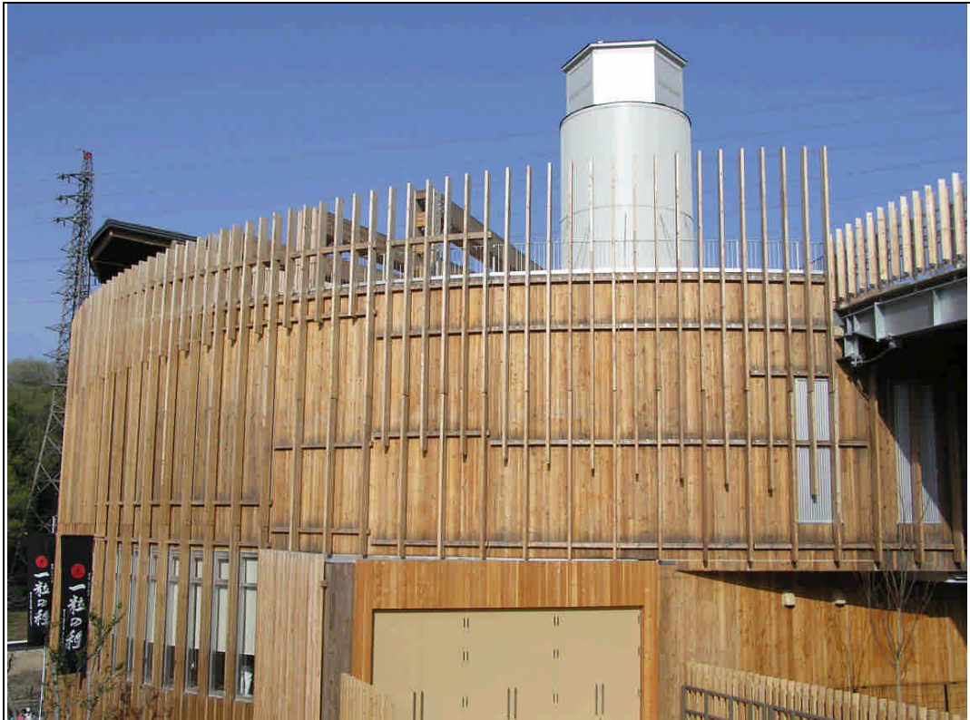
瀨戶日本館外壁採用了耐火木製板，中央風塔改善空調
