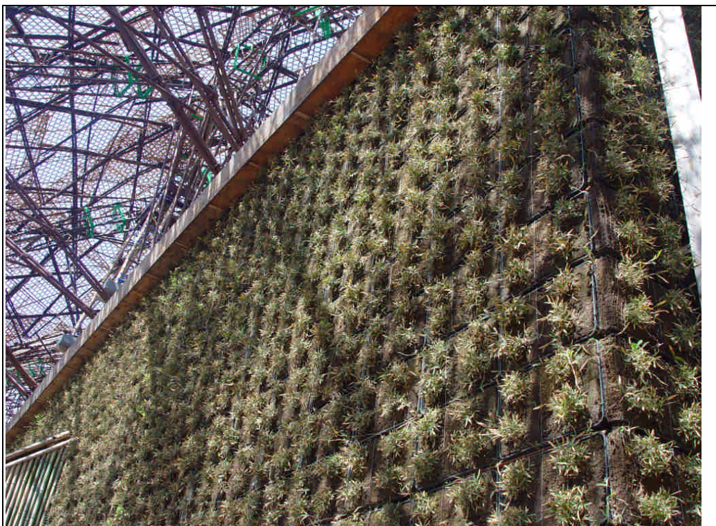
長久手日本館外牆壁面植生綠化及屋頂竹籬巴
