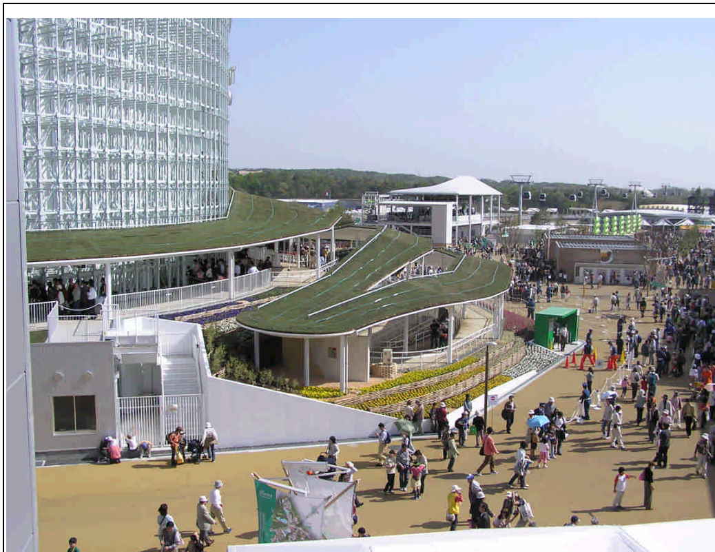
豐田館等待區遮棚屋頂採植生降溫
