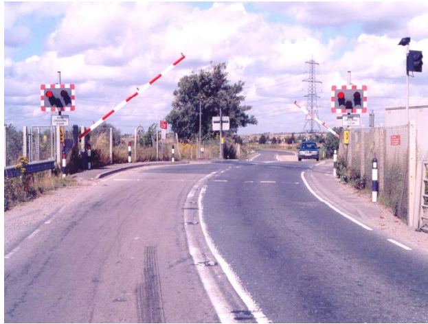
照片七 自動就地監控遮斷式(ABCL)
