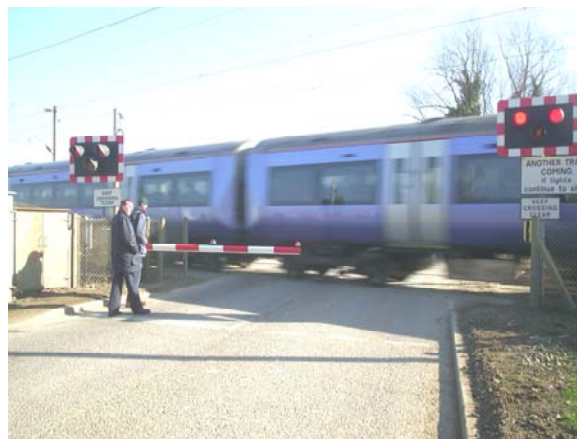
照片三 自動辨識斷平交道(AHB)
