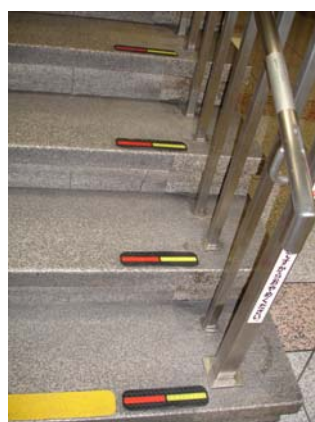
樓梯之緊急反光標誌
