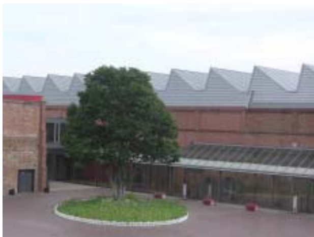
屋頂利用玻璃窗採光，並維持當時工廠斜屋頂樣貌。
