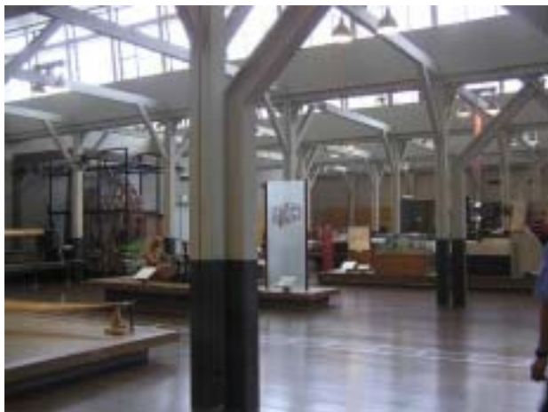
維持原有廠房屋構架，屋頂採透光處理，管線全部鋪設在木地板溝蓋之下，便於維修。
