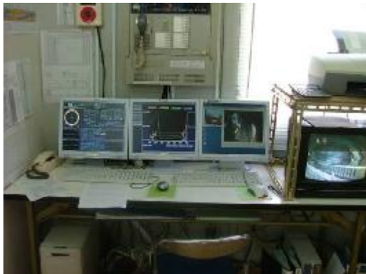
(圖 2-3 辦公室內開挖狀況監測設備)
