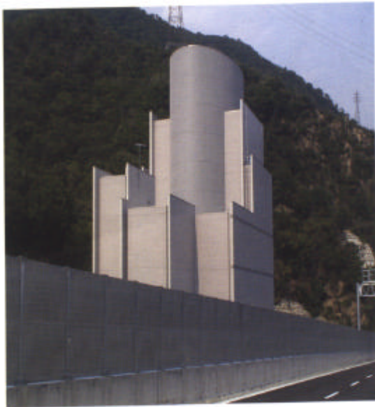
■妙法寺換氣所
