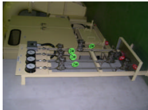
圖 4-7-5：日本蓮宮換氣站機房閘閥之【常開】【常關】壓克力標示牌
