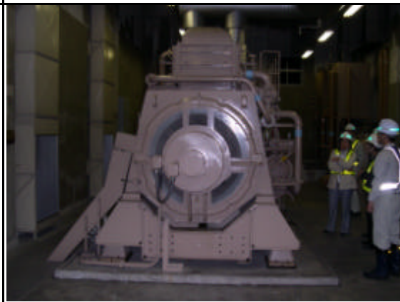
圖 4-5-10 緊急發電機
