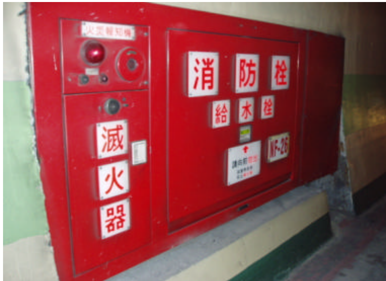
圖 4-1-3：國道三號福德至中和隧道群之輪盤圓管式消防栓箱
