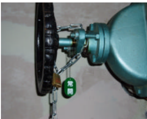
圖 4-7-6：國道三號木柵段機房增設之壓克力標示牌
