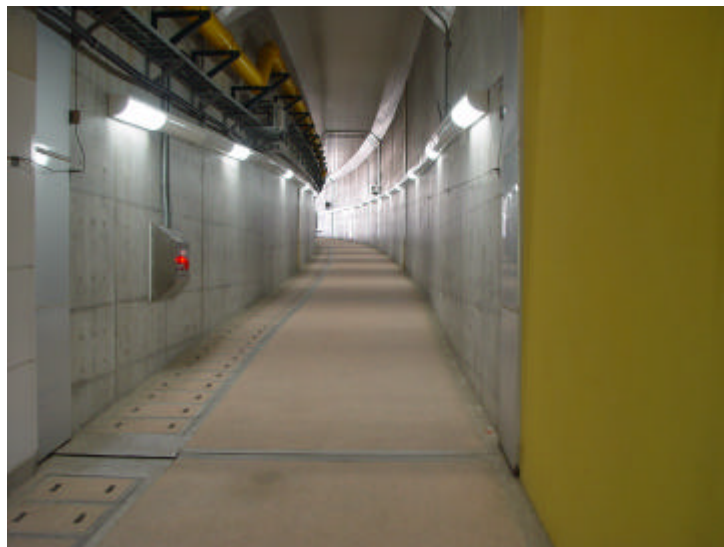
圖 4-6-7：新潟港灣隧道內之自行車道及人行步道
