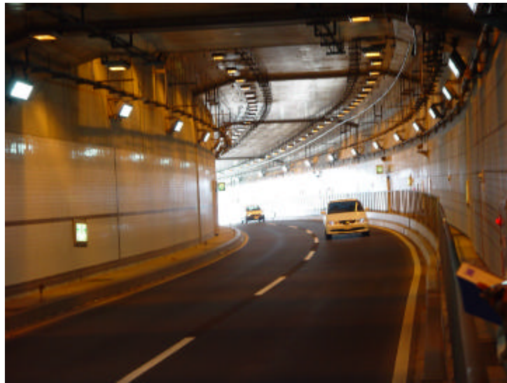
圖 4-6-6：新潟港灣隧道
