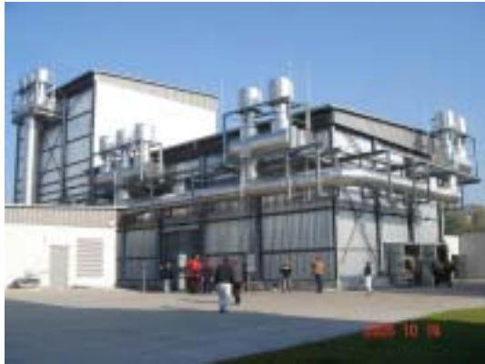
圖 37 IDF 實驗室燃燒館外觀
