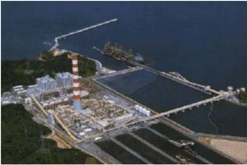
圖 29 J-Power 松島電廠煙囪俯視
