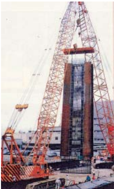
圖 25~26 磯子電廠煙囪施工過程
