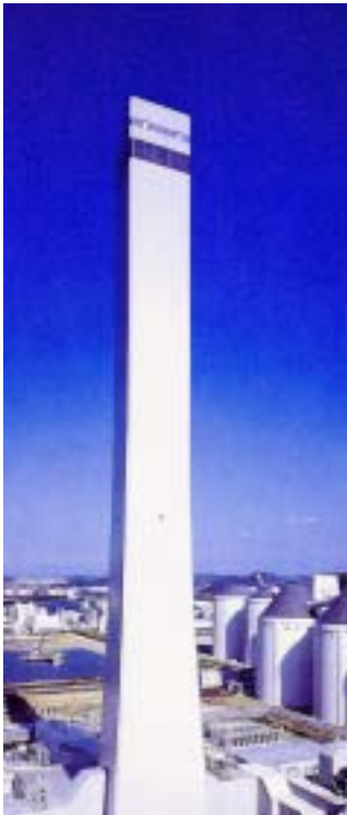
圖 30 J-Power 橘灣電廠煙囪照片
