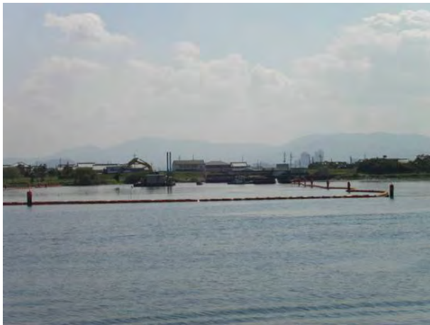
照片 021 琵琶湖-浚渫作業
