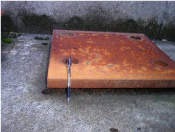
照片 033 出し平水庫-排砂道鋪面鋼板
