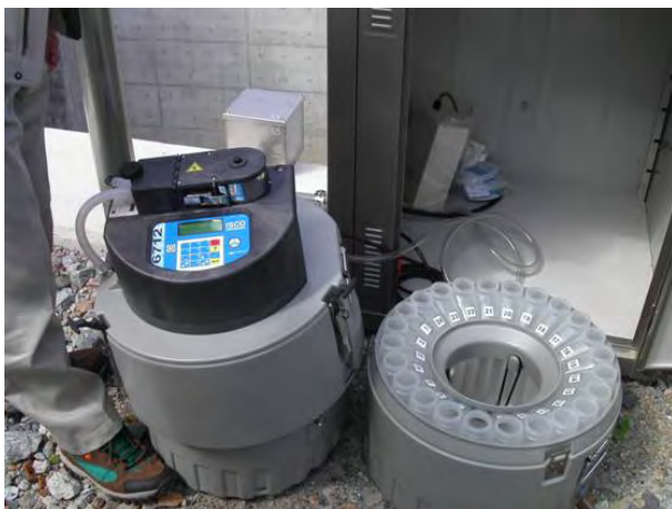
照片 005 美和水庫 bypass 排砂隧道出口懸 浮載水樣取樣設備(2/3)
