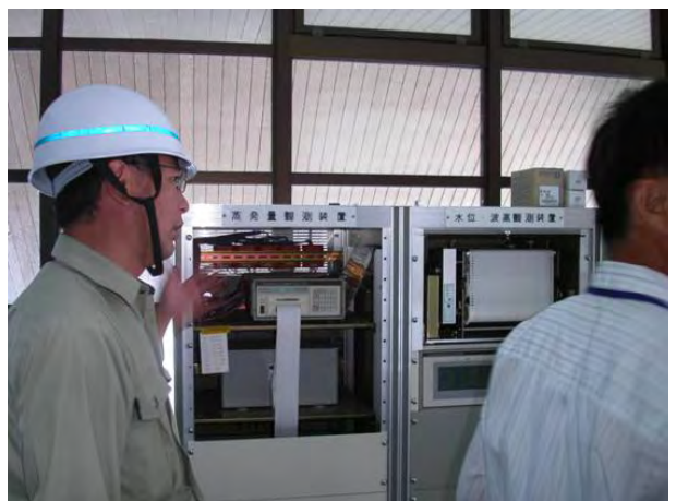
照片 018 琵琶湖-水質自動監測設備
