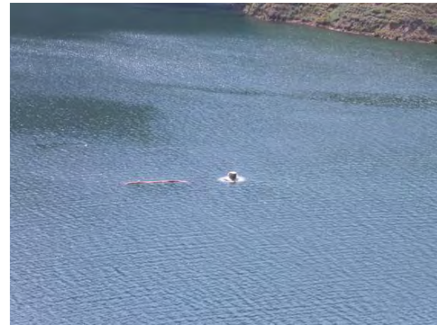
照片 024 日吉水庫-曝氣調整設備
