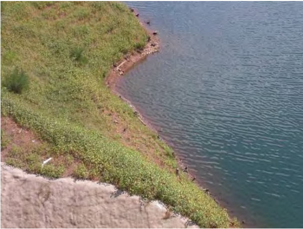
照片 025 日吉水庫-邊坡保護措施
