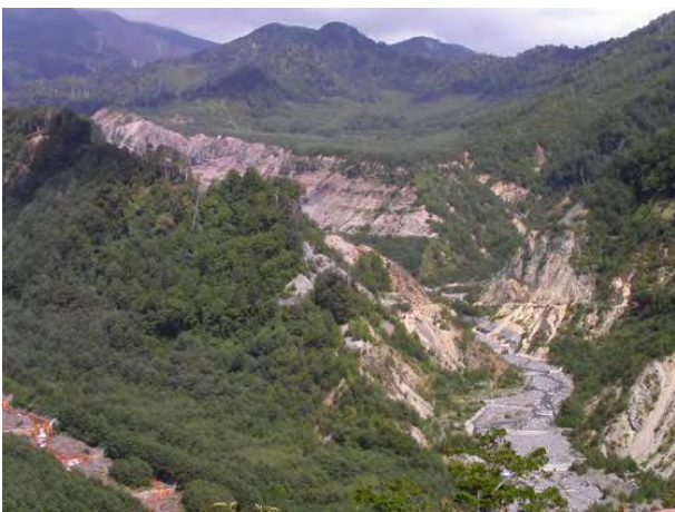
照片 011 牧尾水庫上游集水區攔砂壩及復育現況
