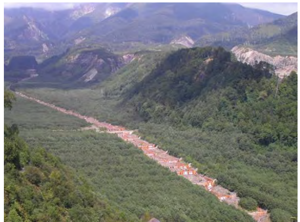
照片 010 牧尾水庫上游集水區崩塌及復育現況
