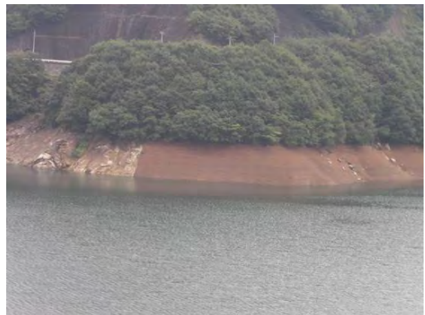
照片 036 草木水庫邊坡種植柳樹之保護設施
