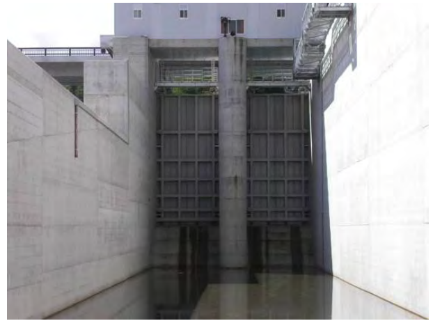
照片 008 美和水庫 bypass 排砂隧道出口消能池
