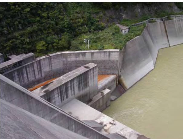
照片 029 宇奈月水庫-側排砂道
