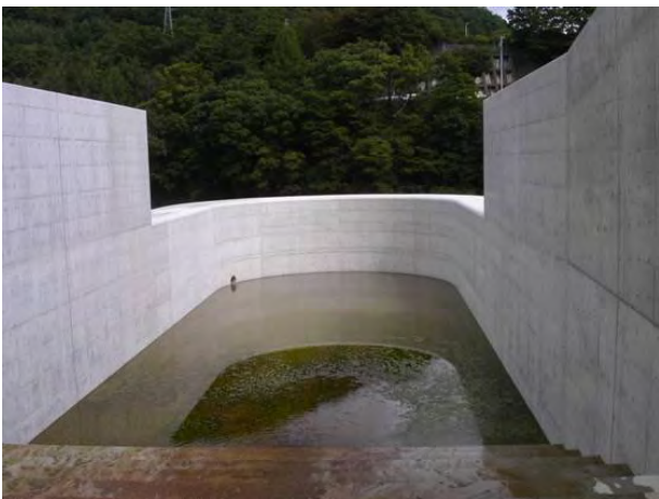
照片 009 美和水庫 bypass 排砂隧道入口閘門
