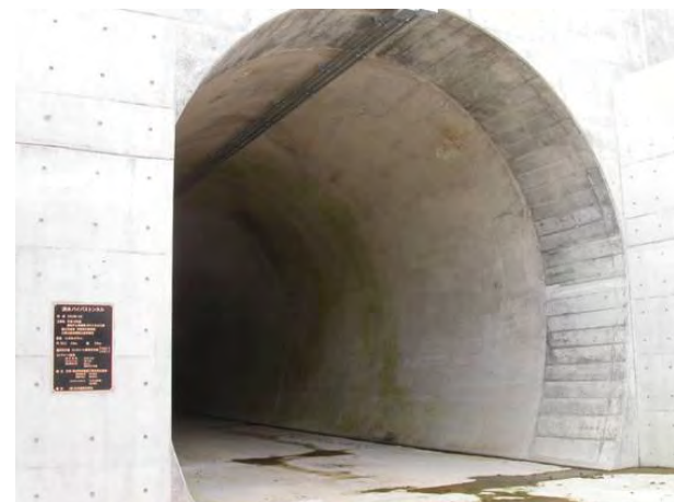
照片 006 美和水庫 bypass 排砂隧道出口懸 浮載水樣取樣設備(3/3)
