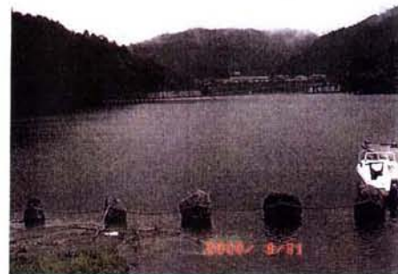
写真-9 布目副ダムの状況（上流から副ダム堤体を望む）
