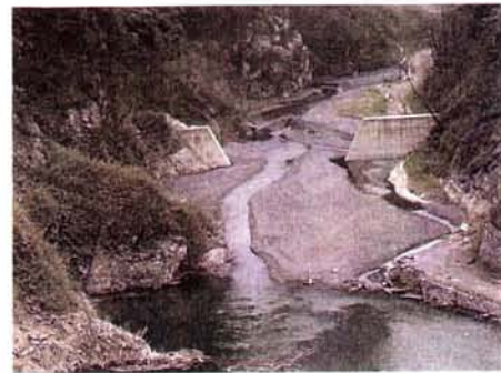
写真-1 浦山貯砂ダムの状況(下流から上流を望む)
