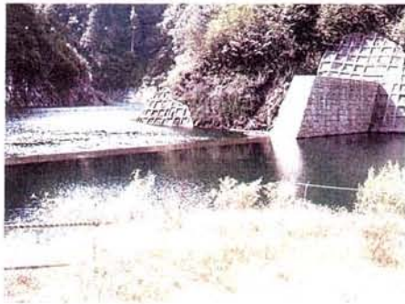
写真-7 味噌川貯砂ダム状況（上流左岸側から右岸を望む）
