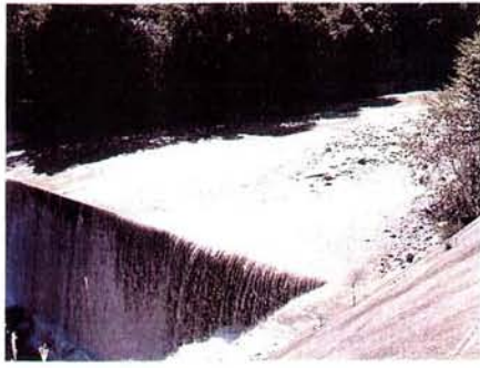
写真-3 阿木川貯留ダム状況（下流側左岸から上流を望む）
