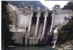
出し平ダム 形式:重力式 高さ:76.7m
