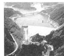
写真-3 阿木川ダム
