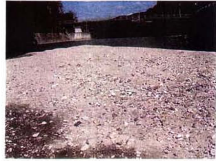
写真-5 岩村川貯留ダム状況 （貯留ダム直上流の陸化箇所、写真上方の吊り橋付近が貯留ダム）
