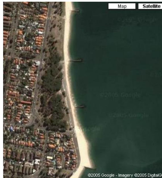
圖 8 突堤式海岸護灘設施
