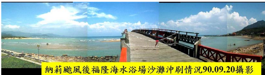
圖 23 90 年納莉颱風後福隆沙灘侵蝕情形
