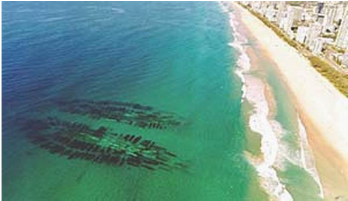
圖 4 砂袋式海底離岸淺堤(Reef)結構物及成效
