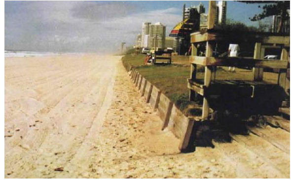
2001 年離岸淺堤(Reef)設置後，暴潮後已改善
