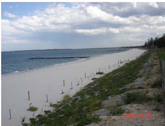
圖 9 自然石塊堆置突堤護灘設施
