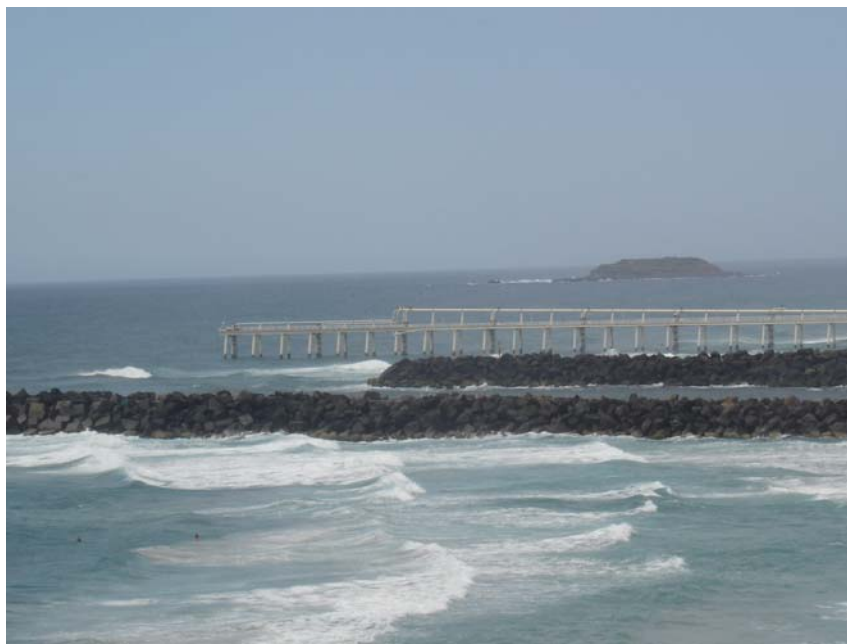
圖 14 抽取 Tweed River 出海口海砂之突堤 (Jetty)
