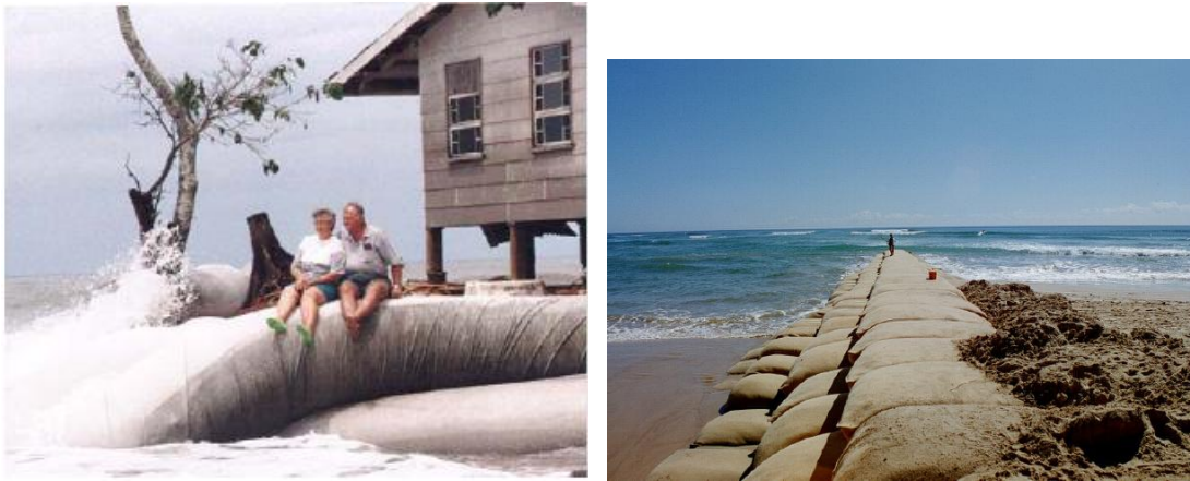
圖 3 砂袋型式之海岸保護結構物
