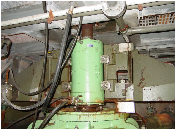
圖 7：Warman 立式灰漿泵軸承
