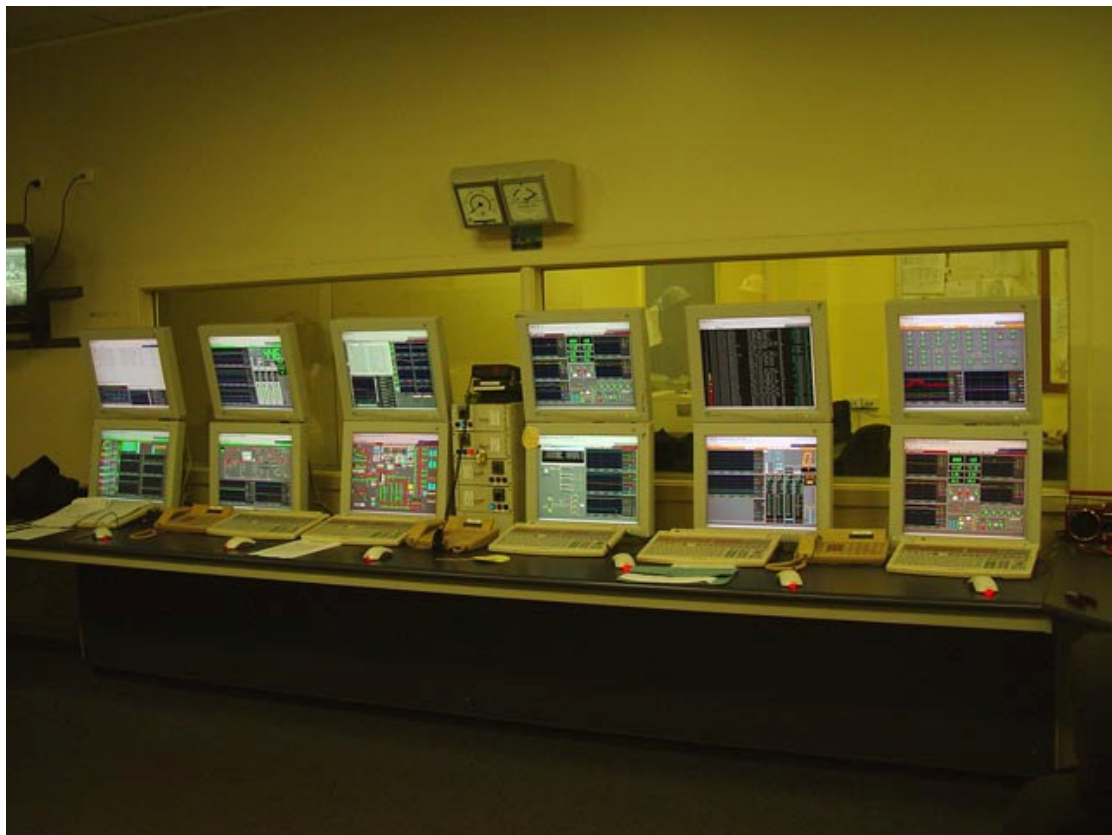
圖 2-8. Liddell 電廠新的 CS3000 DCS 控制系統
