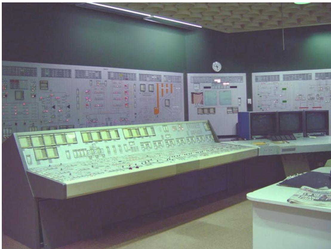
圖 2-2. Eraring 電廠汰換的傳統控制系統、MIMIC 盤
