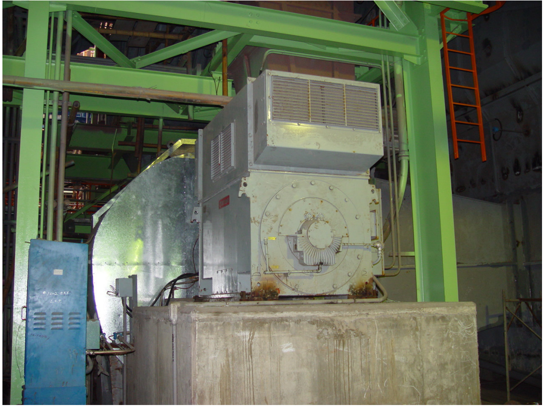
圖 1-8. 台中九、十號機粉煤機一次風風扇
