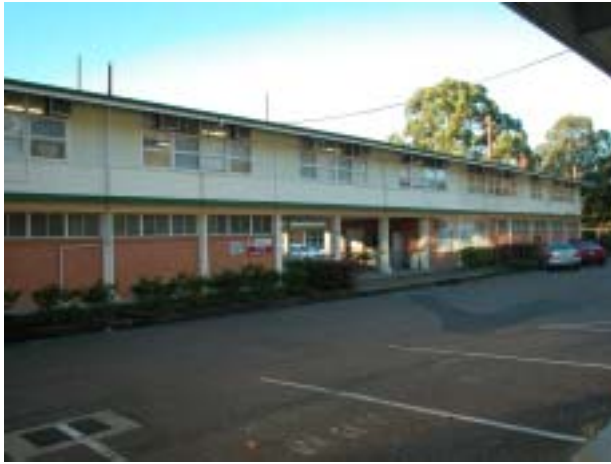
圖 1、位於 Oxley 地區之澳洲紅火蟻防治中心辦公室
