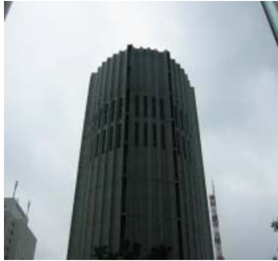
3-207 東京車站豎井
