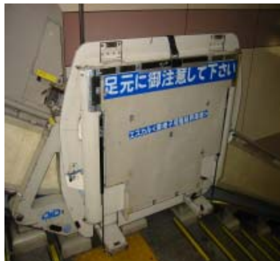
名古屋車站之輪椅用升降設備
