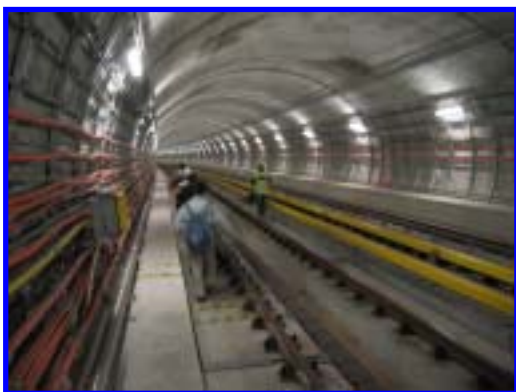
軌道施工方式採用路床施作完成後再架設軌框調整，調整完成後，基板與道床之空隙藉由無縮收混凝土砂漿填補
