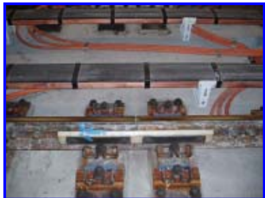
道岔基板及絕緣接頭採用托接方式處理，但其托點間距縮減，以增強及上托強度，絕緣接頭亦使用一般之絕緣接頭
