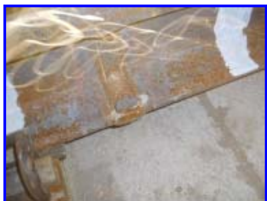
道岔基板及絕緣接頭採用托接方式處理，但其托點間距縮減，以增強及上托強度，絕緣接頭亦使用一般之絕緣接頭
