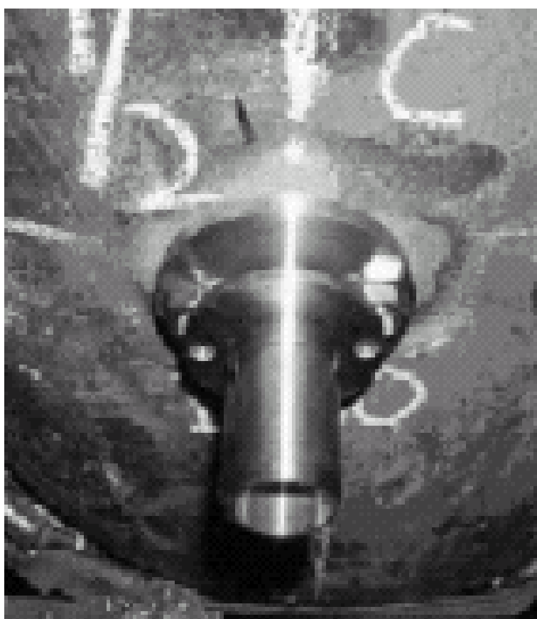
圖 6 現場 SPICA 裝設步驟二：裝設定位插銷與相機固定之夾具
