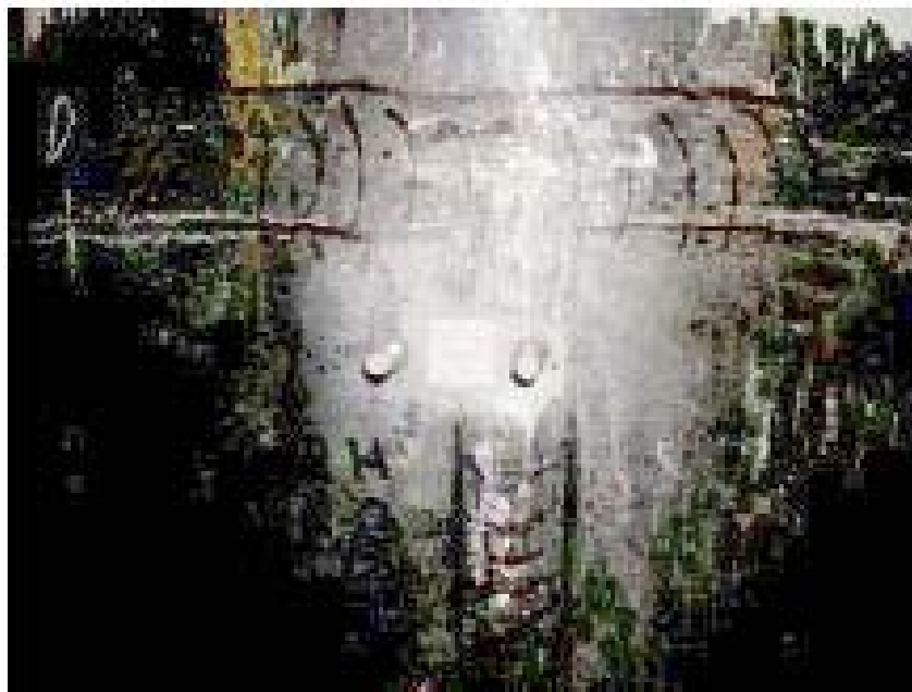
圖 5 現場 SPICA 裝設步驟一：找尋量測位置並在表面噴砂處理使形成粗糙表面
