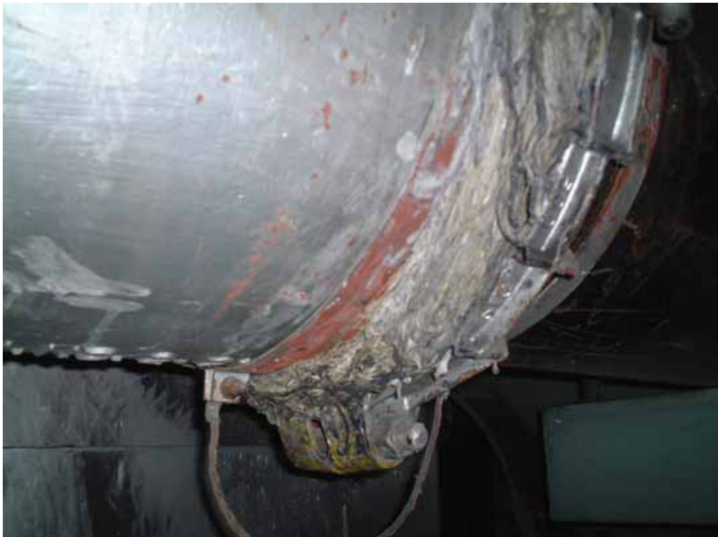
圖 4-10- 2 裝有靜電平衡裝置並包覆陶瓷繩束的粉煤管接頭
