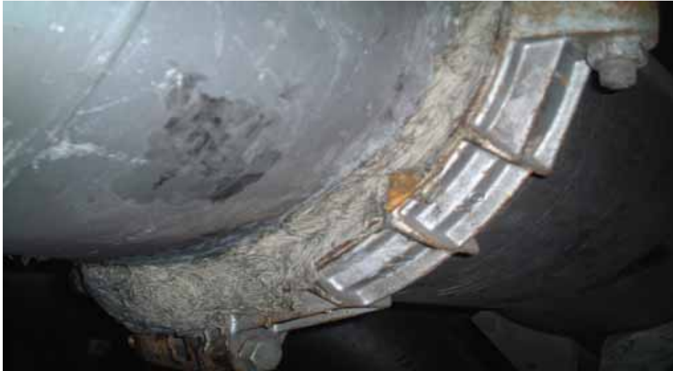
圖 4-10- 1 包覆了陶瓷繩束的粉煤管接頭
