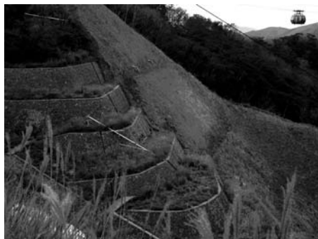
陡坡階段噴植綠化
