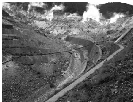
截水溝引水道排放地表水 減除地滑之誘因
