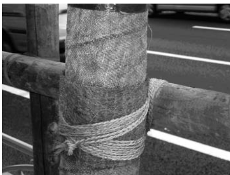
支撐綁法連結細心確實值得效法
