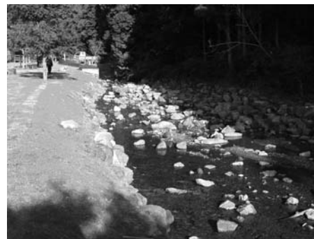
生態工法以在地材料修復的河床工
