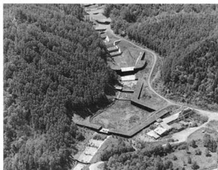
E-2 扇頂部に施工された砂防施設
