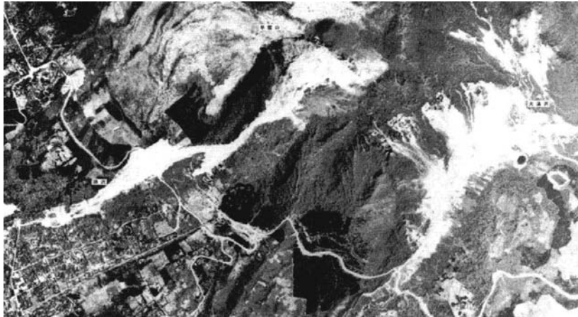
災害發生後的航空照片
