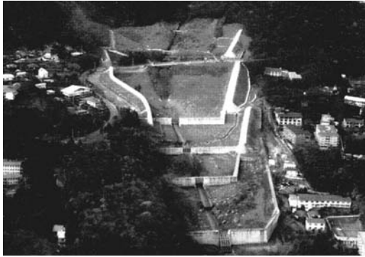
第三期完成的土石流堆積工程
